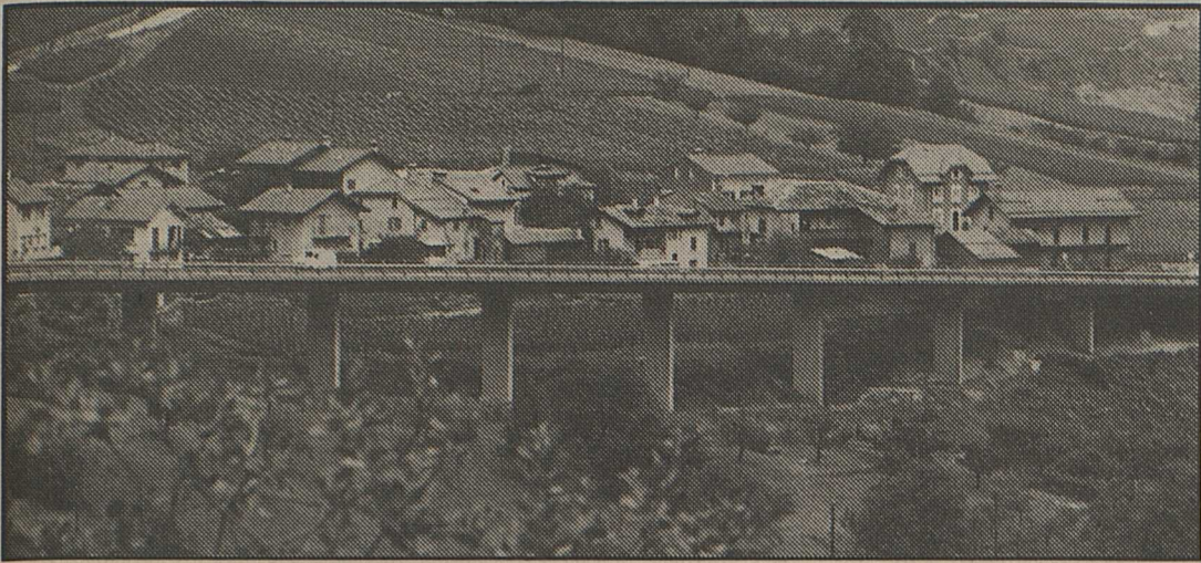
Le viaduc avec derrière le village du Brocard.
