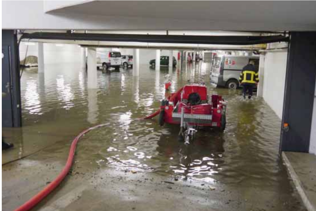
Le commandant du SIS des Montagnes ne s'était jamais retrouvé face à des dégâts d'eau sur des étendues aussi vastes. Ici, le parking du centre commercial des Entilles dans la nuit de dimanche à hier. JÉRÔME BERNHARD
