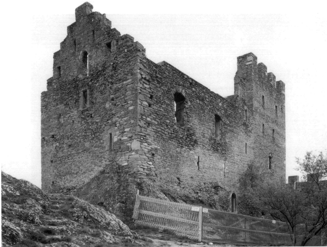
Pl. XIII - Sion, château de Tourbillon vu depuis le sud-ouest. Etat avant restauration.
