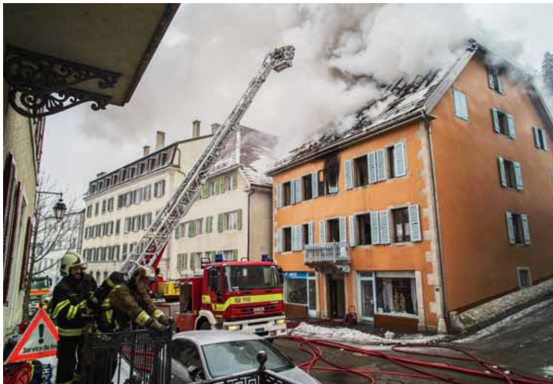
Les fumées chaudes se sont propagées dans les parois et le plancher, boutant le feu aux combles. CHRISTIAN GALLEY
