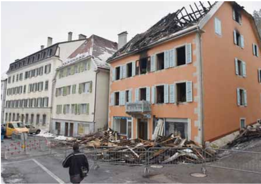
Les trois appartements de la maison incendiée ont été détruits.
