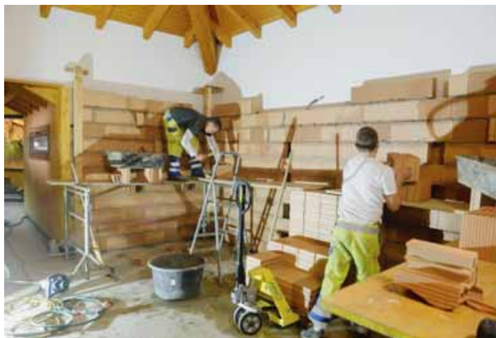
Le Vivarium dans le plus grand chantier qu'il ait jamais vu depuis l'année de sa construction en 1989.
