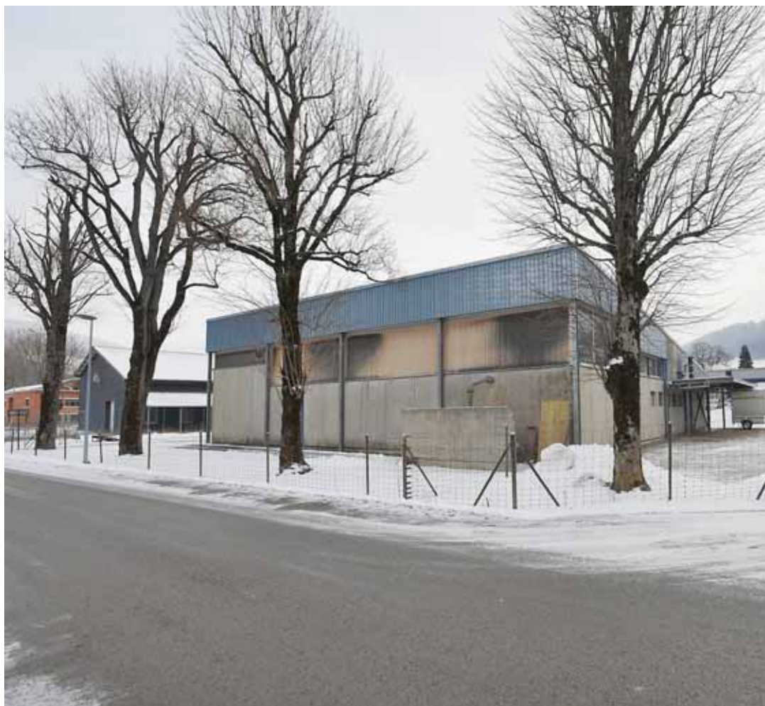
La Coopérative des abattoirs du Val-de-Travers avait pris la décision de fermer les installations môtisannes en mars 2014. ARCHIVES RICHARD LEUENBERGER
