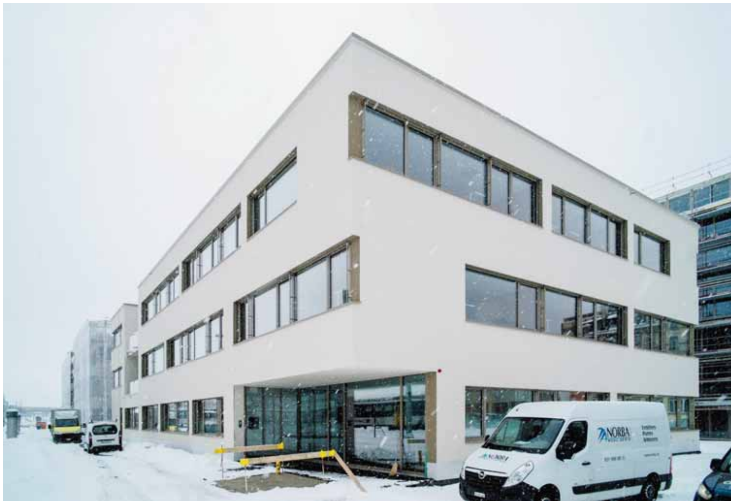
Derrière le bâtiment qui sera occupé par l'Office de l'AI, on devine un des deux locatifs encore en construction. Au fond, dans le prolongement de l'AI en bordure des voies CFF, l'autre bâtiment administratif qui sera intégré par l'Orif. CHRISTIAN GALLEY
