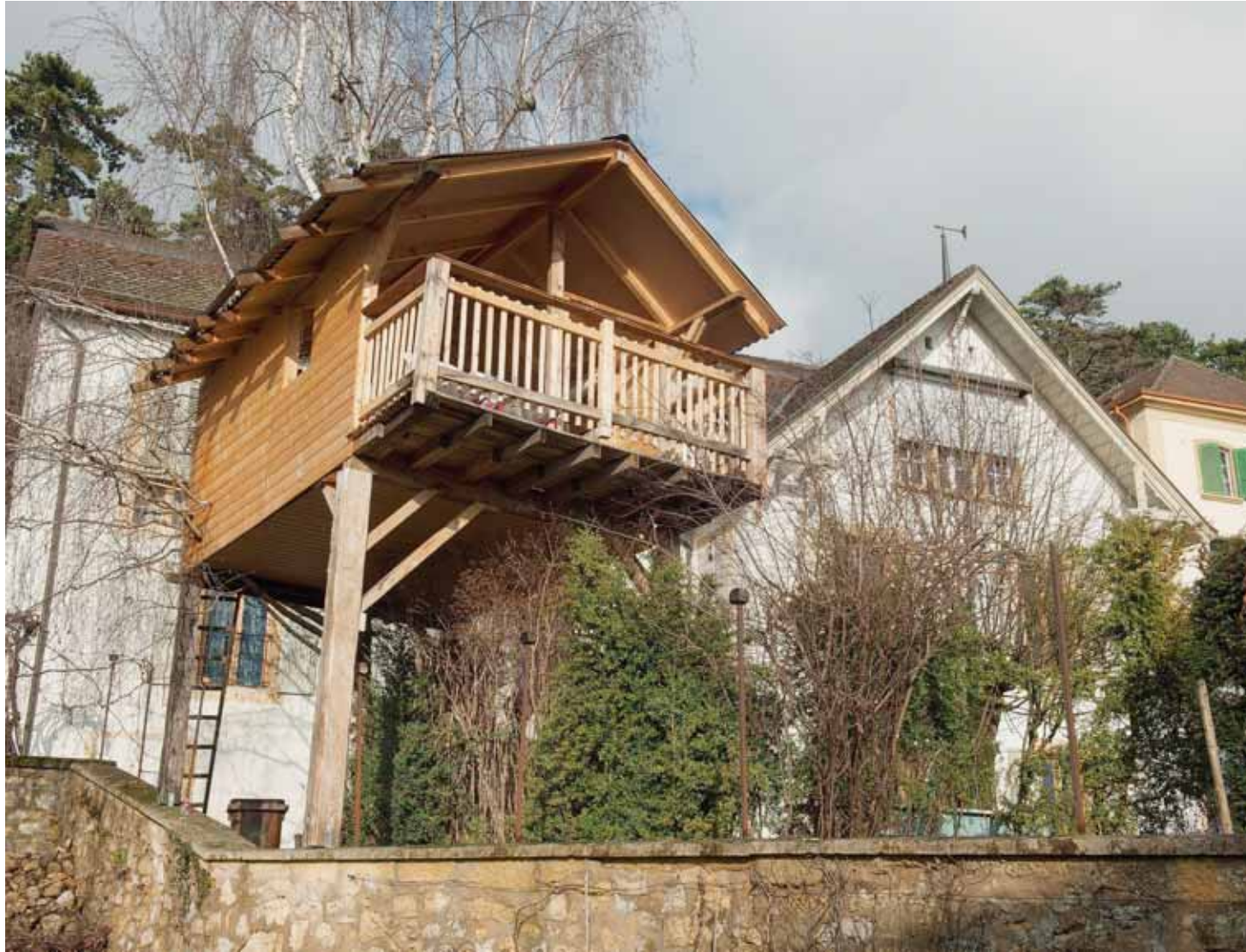
La maisonnette construite dans son jardin par un Neuchâtelois et ses deux fils mesure quatre mètres de long et un peu plus de deux mètres de large. Elle est soutenue par quatre pilotis et appuyée sur un bouleau. DAVID MARCHON
