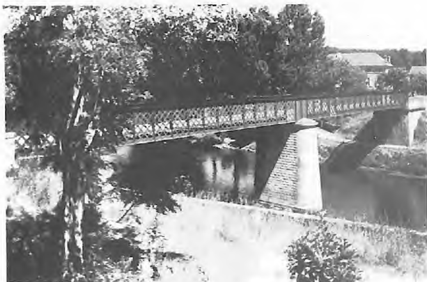
Pont métallique à Saint-Léon-sur-Vézère.
