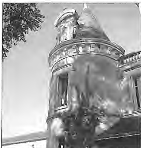
Fig. 4. Tour de la façade du château de Laubertie (cliché M.-N. Chabry)
