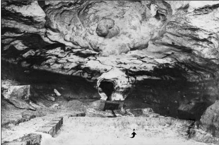
Fig. 4. La Salle des Taureaux vers 1947. Photo de la collection Laval montrant les travaux d'aménagement pour l'ouverture touristique de la caverne, en particulier le remblaiement de l'effondrement devant l'entrée du Diverticule axial et le trou d'évacuation à la base de la paroi du dernier gour (f èche).
