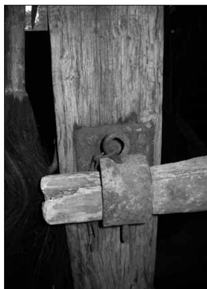
Fig. 13. Goupille d'immobilisation de la barre arrière.
