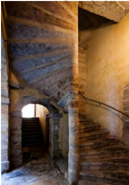
Fig 7 : Escalier en colimaçon d'une traboule de la Croix Rousse, Lyon
