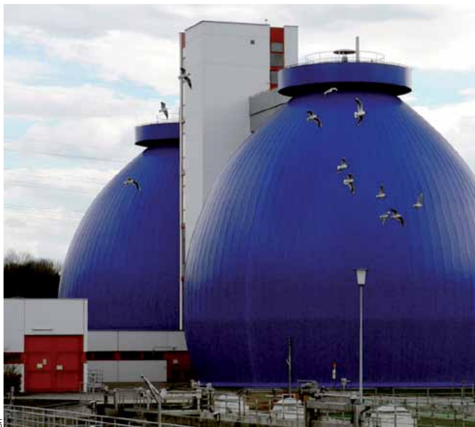
DR Digesteurs à l'usine d'Oberzell (Allemagne).
