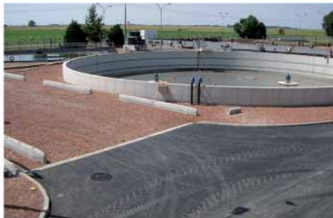
Station d'épuration industrielle 100 000 EH
