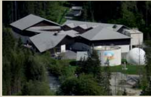
Station d'épuration du Sivom de la vallée d'Aups à Essert-Romand (Haute-Savoie)
