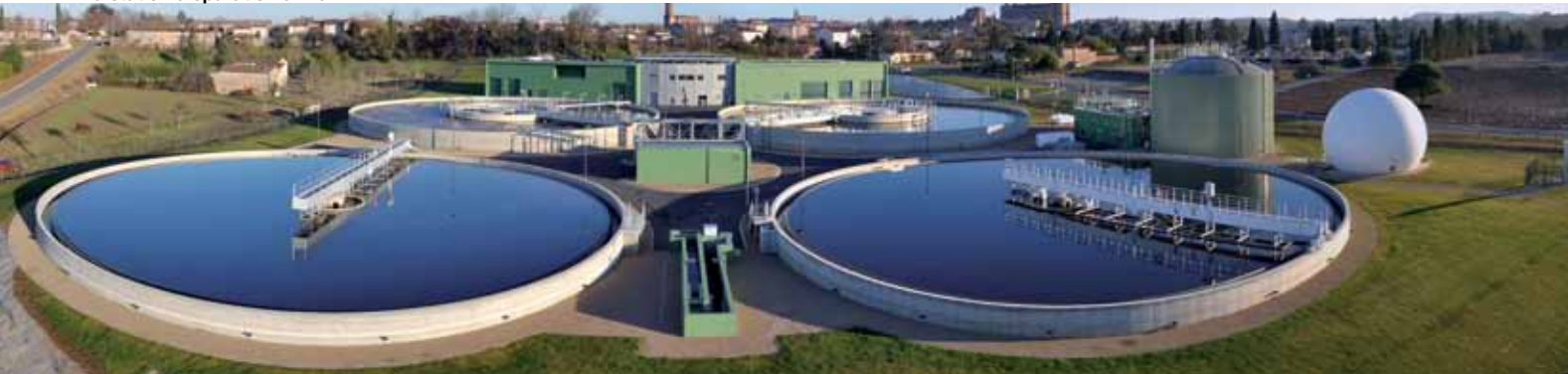
La station d'épuration d'Albi.
