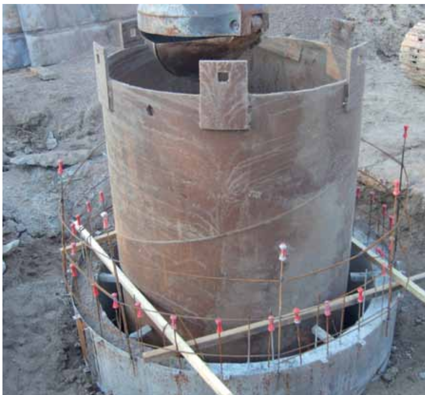
Tubage lourd de soutènement.
