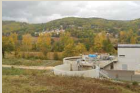
Station d'épuration du SIVU du Pays d'accueil de la Vallée du Lot à Banassac (Lozère)
