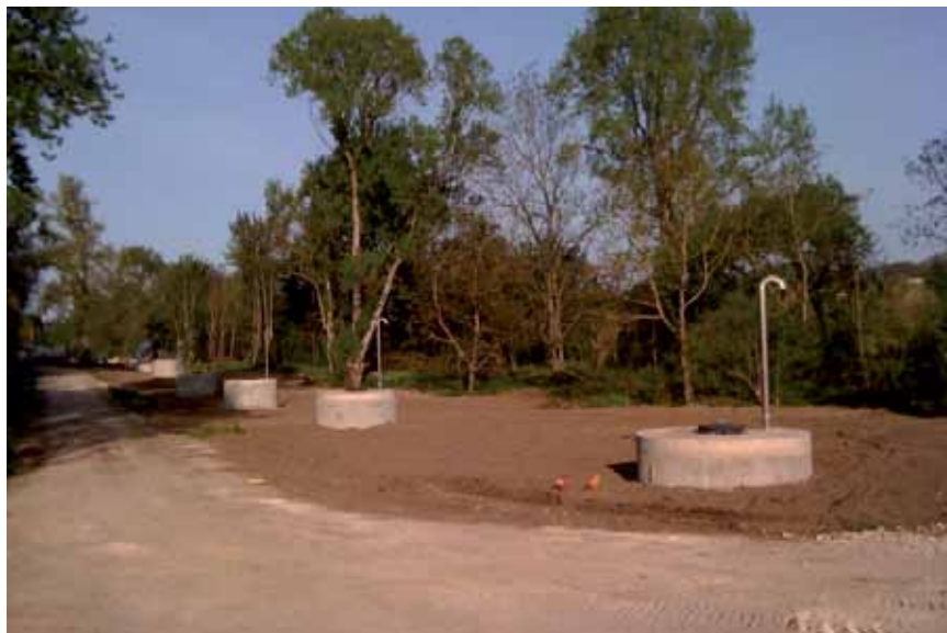
Vue d'ensemble sur les puits terminés.
