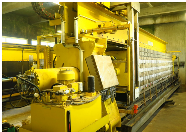
Usine de Villejean Filtre presse à conserver dans la refonte
