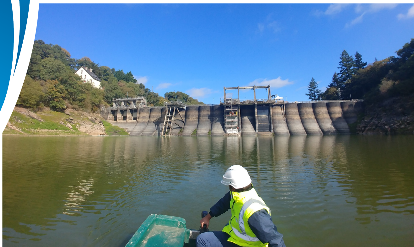
Barrage de Rophémel : importants travaux en 2018
