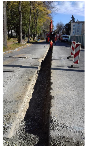
Travaux de renouvellement d'une conduite d'eau potable Boulevard Emmanuel Mounier - Rennes Octobre 2018
