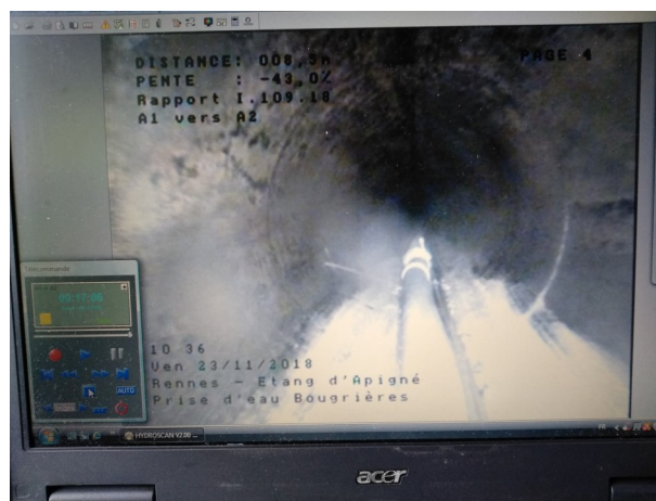
Curage de la conduite d'acier avec présence de sable Étang des Bougrières 23 novembre 2018
