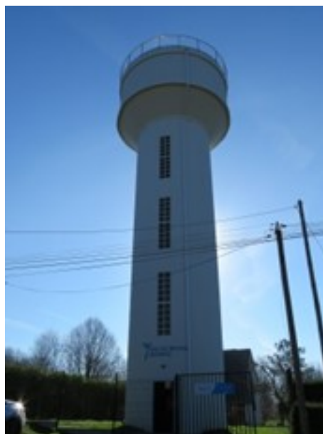
Réservoir après travaux
