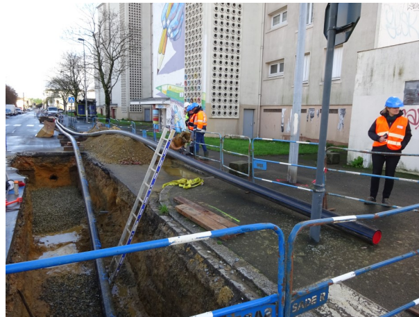
Travaux de renouvellement d'une canalisation d'eau potable Rue Champion de Cicé - Rennes Décembre 2018
