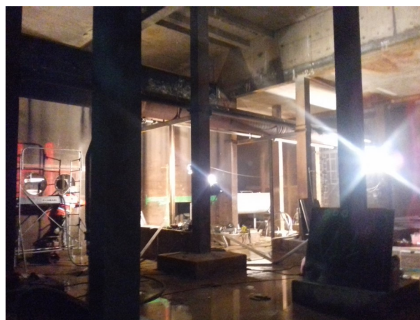
Travaux dans la citerne n° 2 de l'usine de Villejean Février 2018
