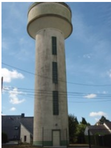
Réservoir avant travaux
