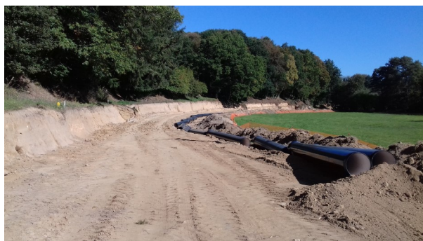
Travaux de renouvellement du tronçon Bigotière Août 2018
