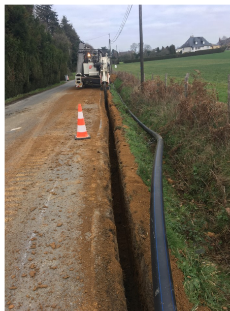
Renouvellement d'une conduite en PEHD 125 mm par trancheuse Tihouit - VC 5- Betton Décembre 2018
