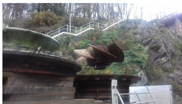
Démontage de la roue du groupe alternateur Centrale hydroélectrique de Rophémel 14 mars 2018
