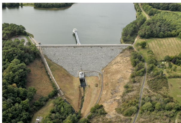
Vue aérienne du barrage de la Chèze Saint-Thurial © Michel COUELLE
