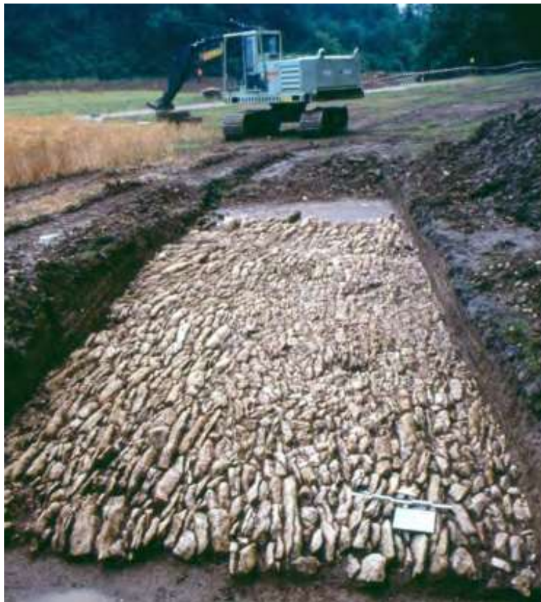
Fig. 19 La voie romaine à Courtedoux, vue transversale du hériçon © OCC-SAP.
