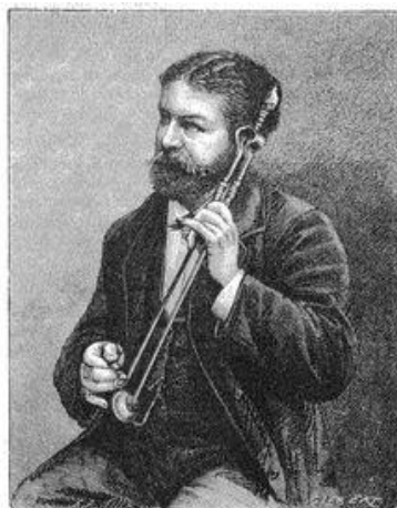
Fig. 1. — Conductibilité des métaux pour le son. — Le tic-tac d'une montre entendu à l'extrémité d'une paire de pincettes.
