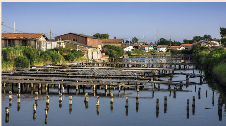
Ferme ostréicole, Bassin d'Arcachon.
