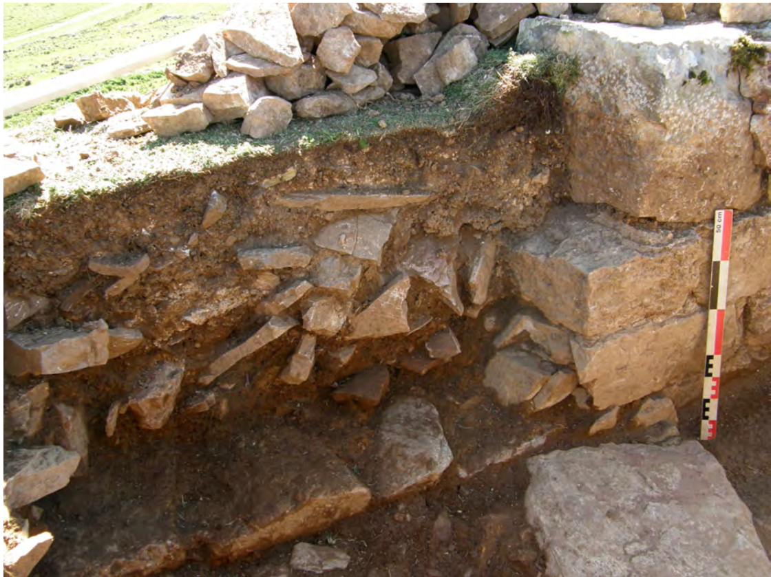
Photo 38 - S17 : arrachement au niveau d'une ancienne niche (photo C. Normand).
