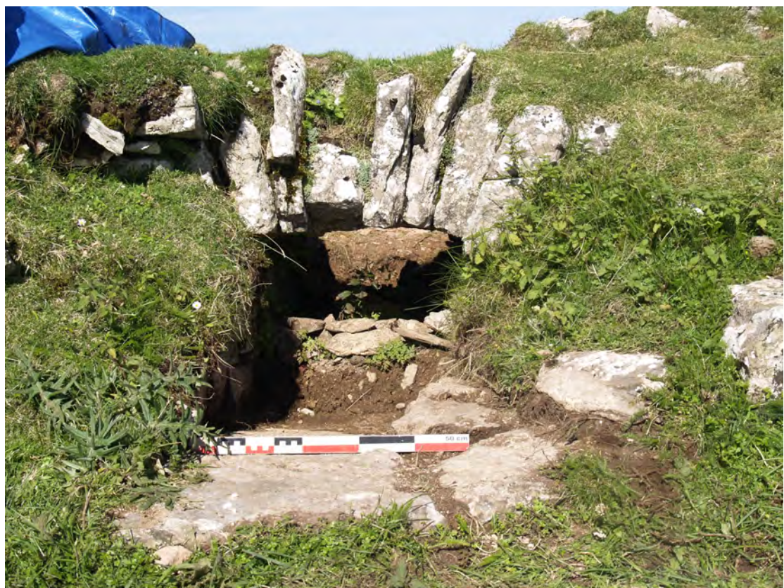
Photos 55 et 56 - Vues de la canonnière 2, prise de l'intérieur de la tour, avant et après nettoyage (photos C. Normand).
