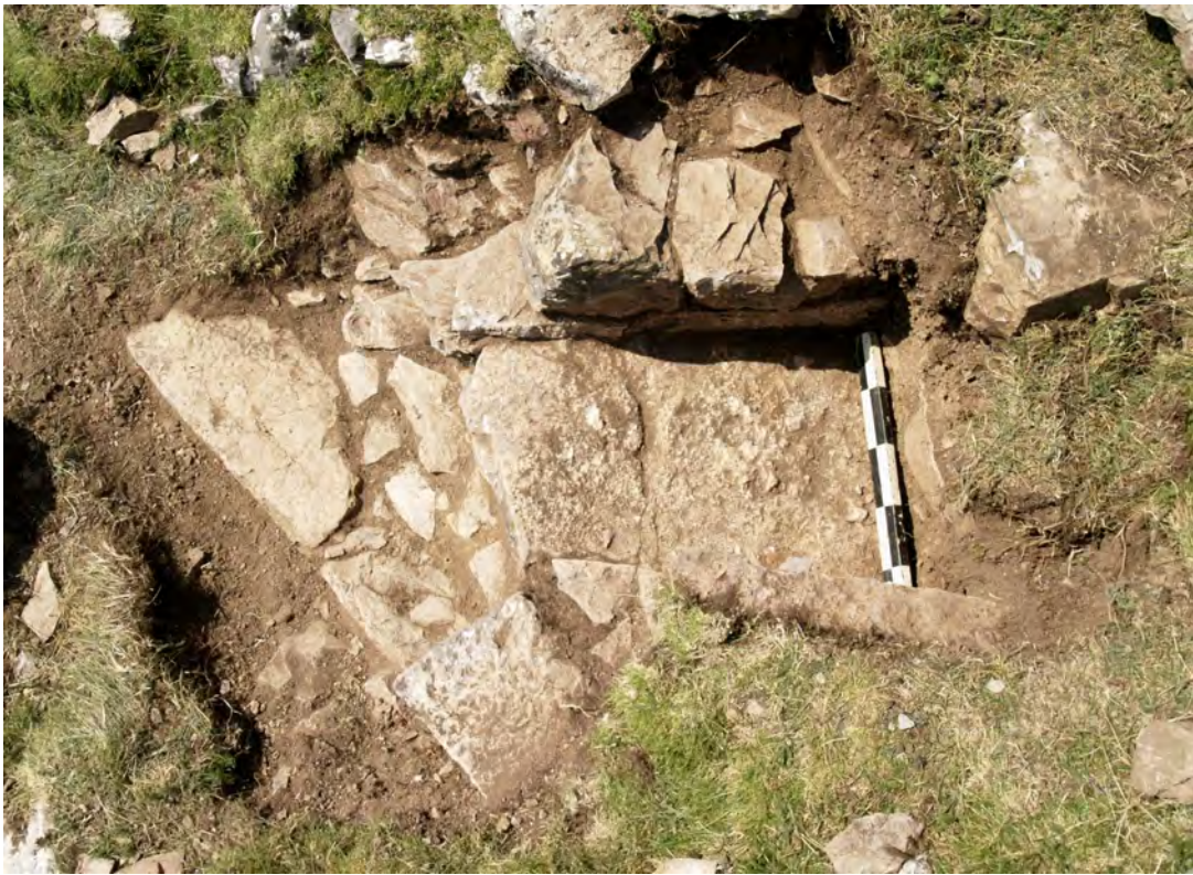
Photos 64 et 65 - S3 : vestiges de l'ouverture intérieure de la canonnière 3. En haut, vus de face ; en bas, vus de haut (photo B. Duvivier).
