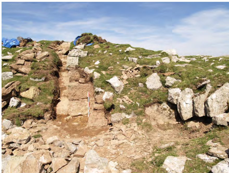
Photo 42 - Canonnière 1 en cours de dégagement ; à droite les vestiges de la voûte d'une autre canonnière ouverte dans la tour (Photo B. Duvivier).
