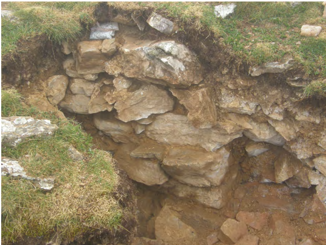
Photo 98 - S8 : piédroit « sud » (photo C. Normand).
