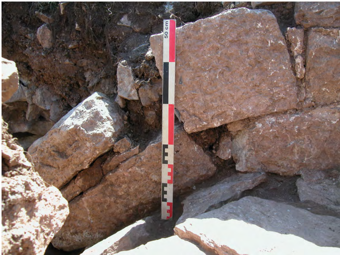
Photo 78 - S5 : dalles et parement en partie effondrés (photo G. Parent).
