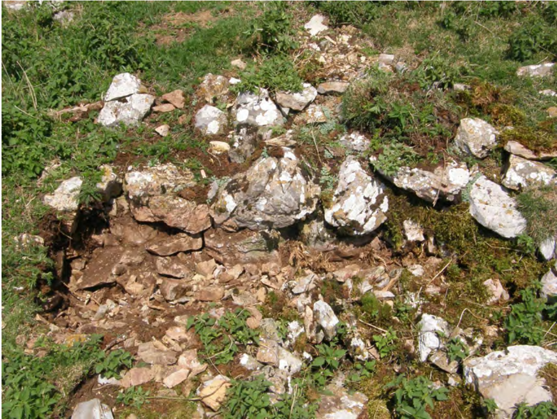
Photo 46 - S14 : parement extérieur du mur (photo C. Normand).
