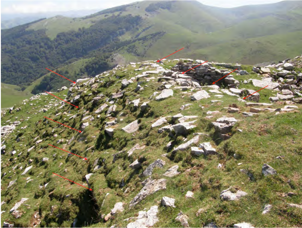
Photo 90 - Emplacement des parements externe (à gauche) et interne (à droite) du mur sud-est (photo C. Normand).
