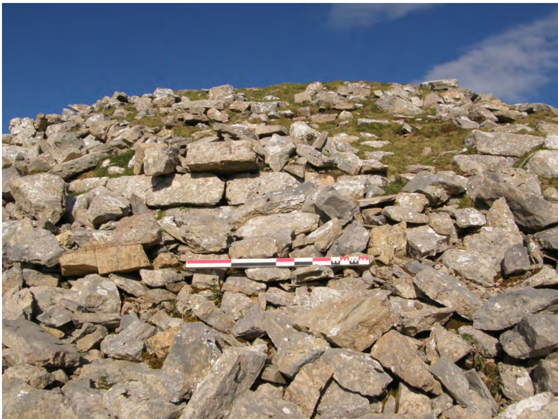
Photo 52 - Blocs avec fruit de la base de la tour émergeant des éboulis, certains sont déplacés (photo C. Normand).
