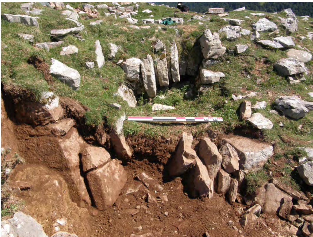
Photo 60 - S9 : dalles provenant de l'effondrement de la voûte (photo C. Normand).
