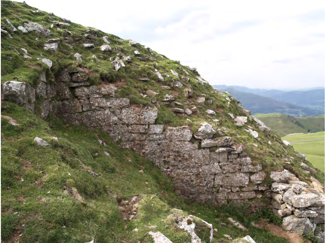
Photo 19 - Vue de la partie en retrait du mur nord-est (photo B. Duvivier).
