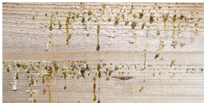
Fig. 1 : Exsudation de résine sur un bardage extérieur
