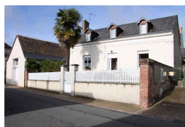
2, rue Principale. Phot. Jean-Baptiste Darrasse IVR52_20087202455NUCA
