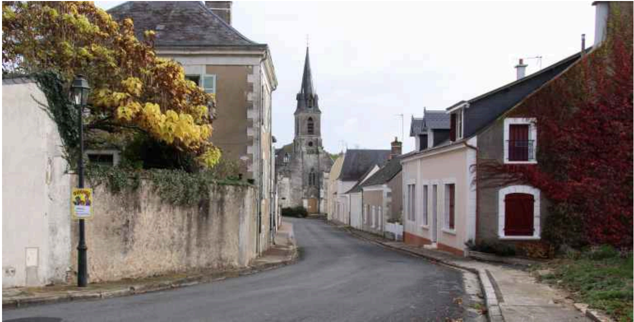
Vue d'ensemble de la rue Principale prise du Paty.
