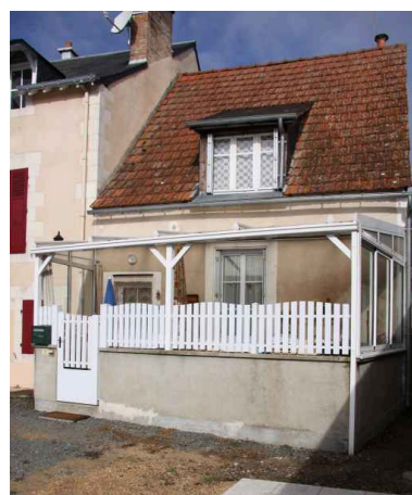
7, rue Principale : façade sur cour. Phot. Jean-Baptiste Darrasse IVR52_20087202449NUCA
