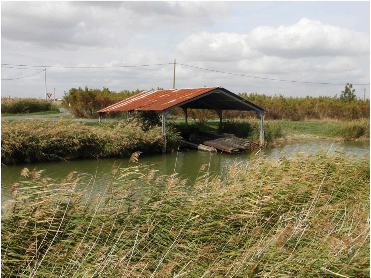
Le bac à râteau sous son abri, au bord du canal du Clain, vu depuis le sud-est.
