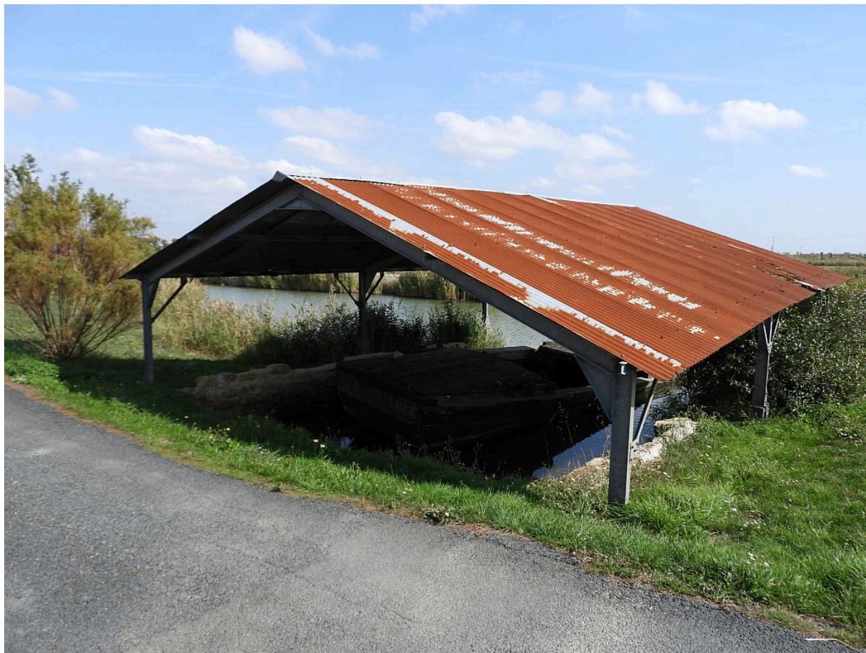
L'abri du bac à râteau vu depuis l'ouest.
