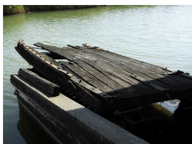
Une des ailes du râteau, déposée à plat sur la partie avant du bac. Phot. Yannis Suire IVR52_20188500423NUCA
