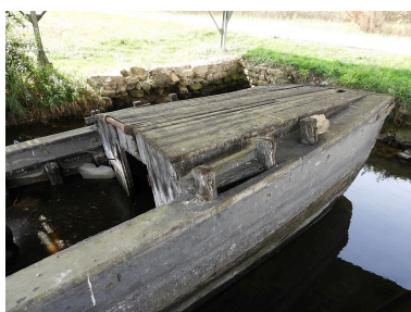
Abri à l'arrière du bac. Phot. Yannis Suire IVR52_20188500424NUCA
