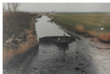
Manoeuvre d'un bac à râteau sur le canal de l'Epine, à Puyravault, vers 1980. Phot. Yannis (reproduction) Suire IVR52_20188500968NUCA
