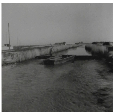
Le bac du Petit-Poitou dans le canal du Clain, en amont de la porte des Grands Greniers, vers 1960. Phot. Yannis (reproduction) Suire IVR52_20188501040NUC
