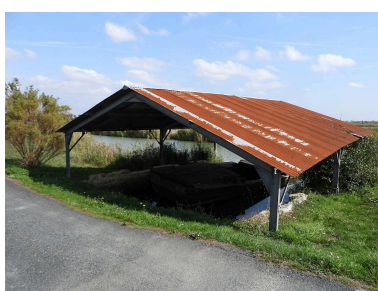
L'abri du bac à râteau vu depuis l'ouest. Phot. Yannis Suire IVR52_20188500419NUCA
