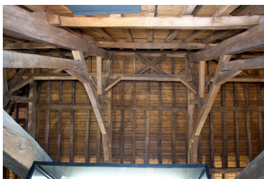
Vue de la charpente. Phot. Denis Pillet IVR52_20064401514NUCA
