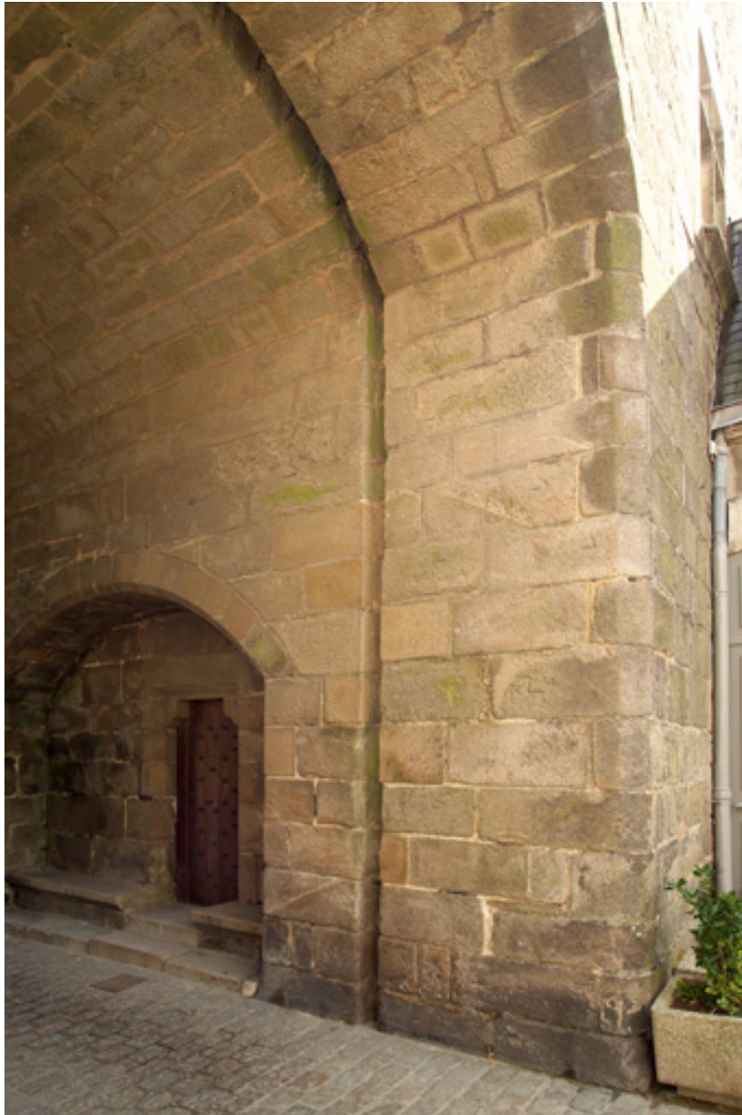
Vue du passage, détail de la feuillure de herse et de la porte ouvrant dans la tour sud.
