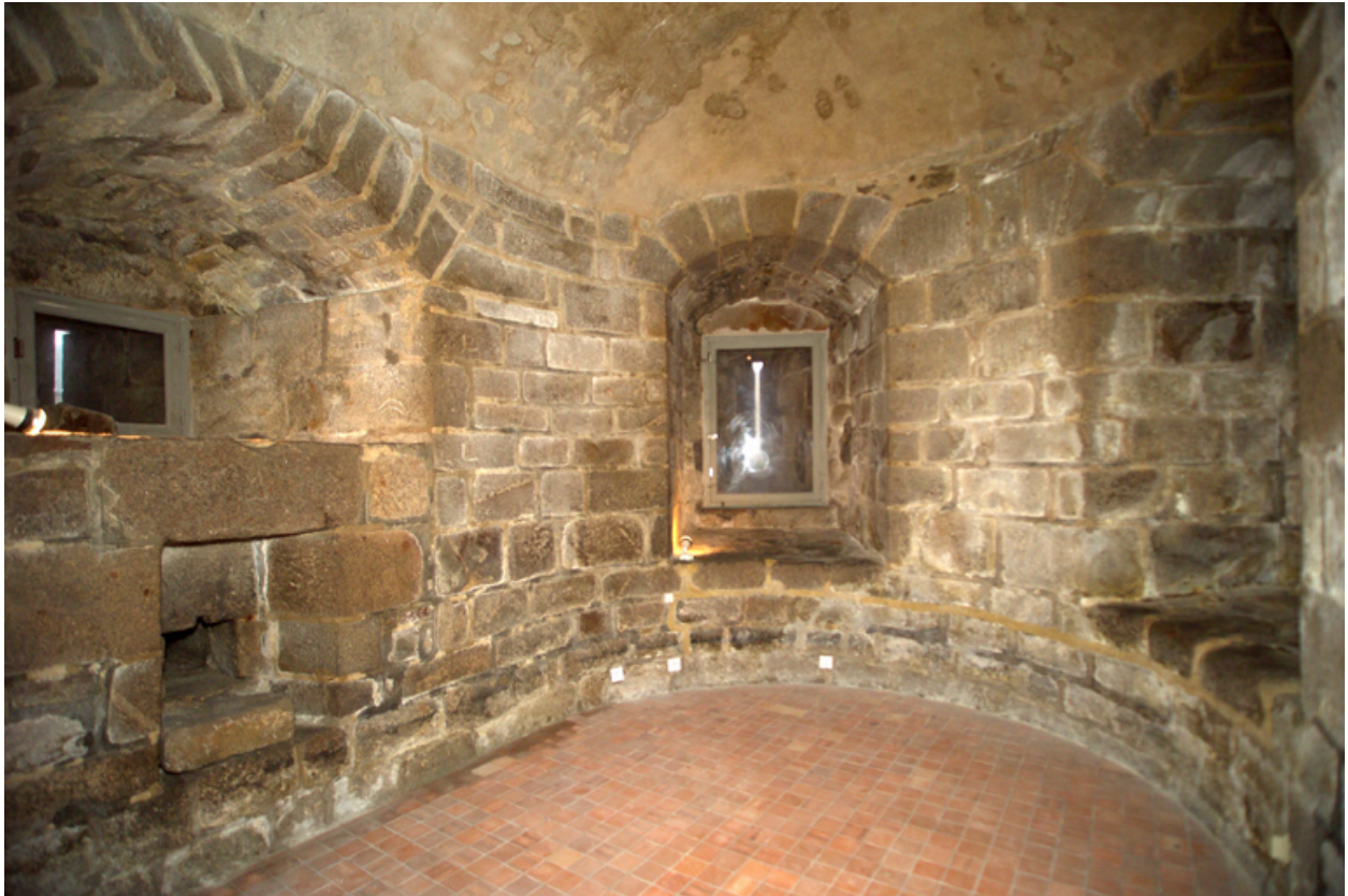
Rez-de-chaussée de la tour sud, salle semi circulaire.
