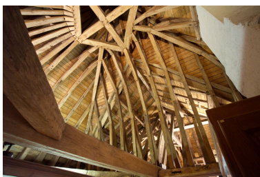
Vue de la charpente, couvrement de tour. Phot. Denis Pillet IVR52_20064401517NUCA
