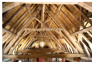
Vue de la charpente. Phot. Denis Pillet IVR52_20064401519NUCA
