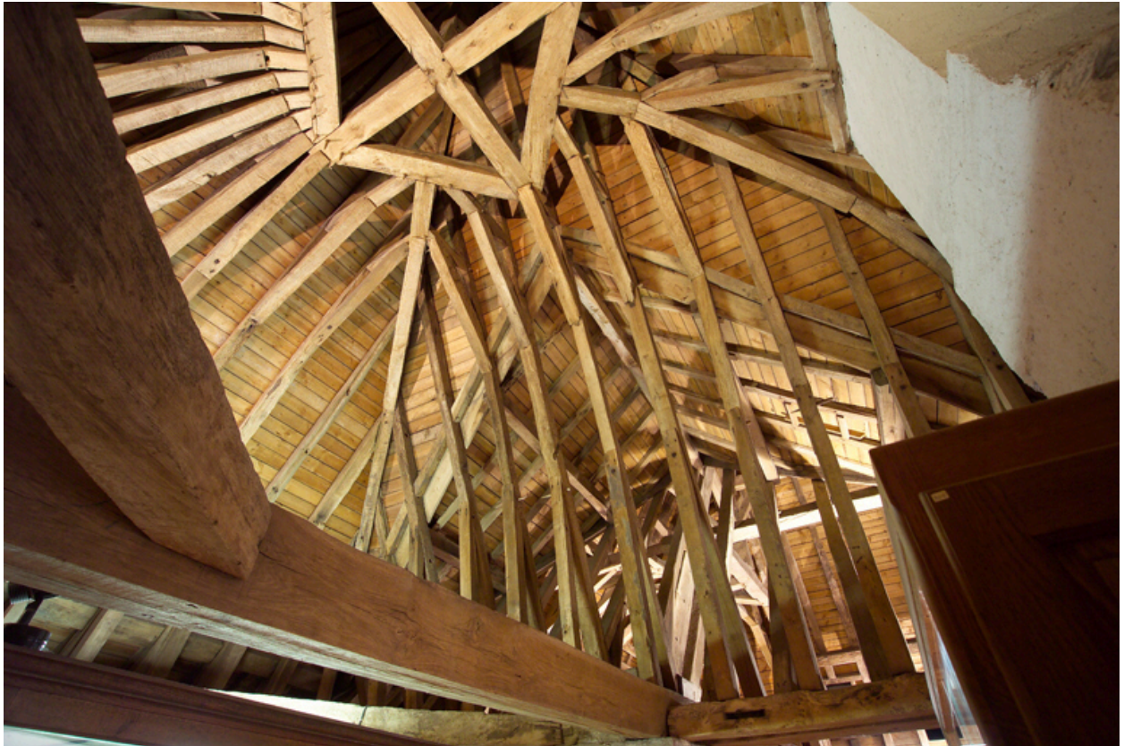
Vue de la charpente, couverture de tour.
