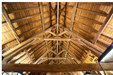
Vue de la charpente. Phot. Denis Pillet IVR52_20064401518NUCA
