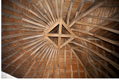
Vue de la charpente, couvrement de tour. Phot. Denis Pillet IVR52_20064401516NUCA
