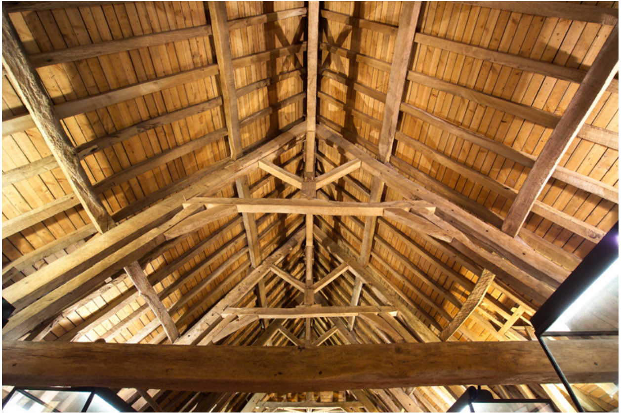
Vue de la charpente.
