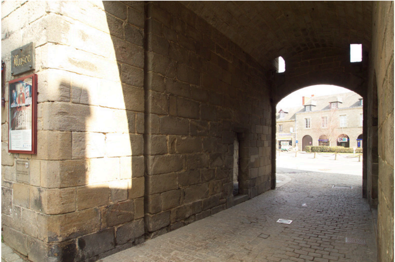
Vue du passage, parement nord.
