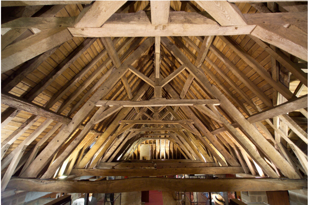
Vue de la charpente.
