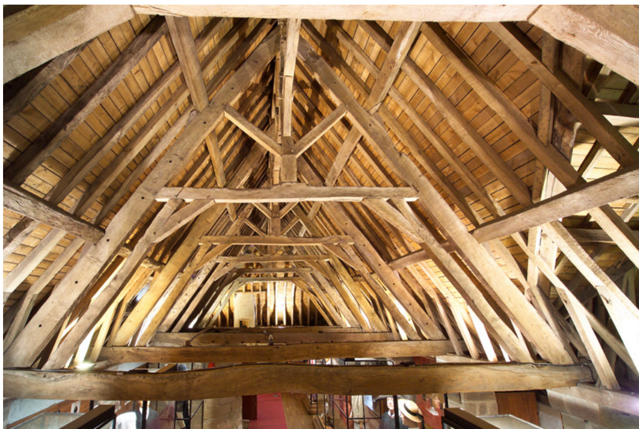
Vue de la charpente.
