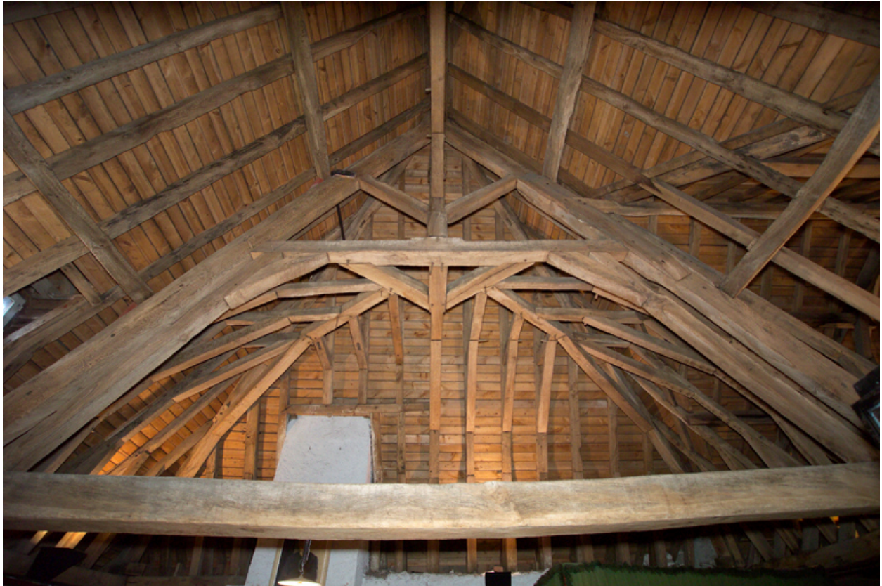
Vue de la charpente, croupe.
