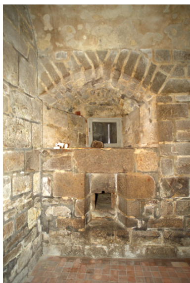
Ouverture de tir au rez- de-chaussée de la tour sud. Phot. Denis Pillet IVR52_20064401533NUCA
