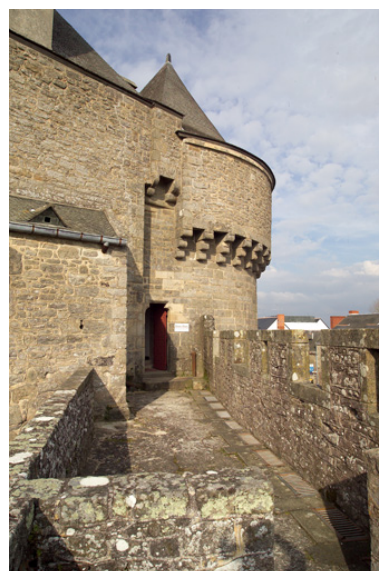
Vue depuis le chemin de ronde. Phot. Denis Pillet IVR52_20064402141NUCA
