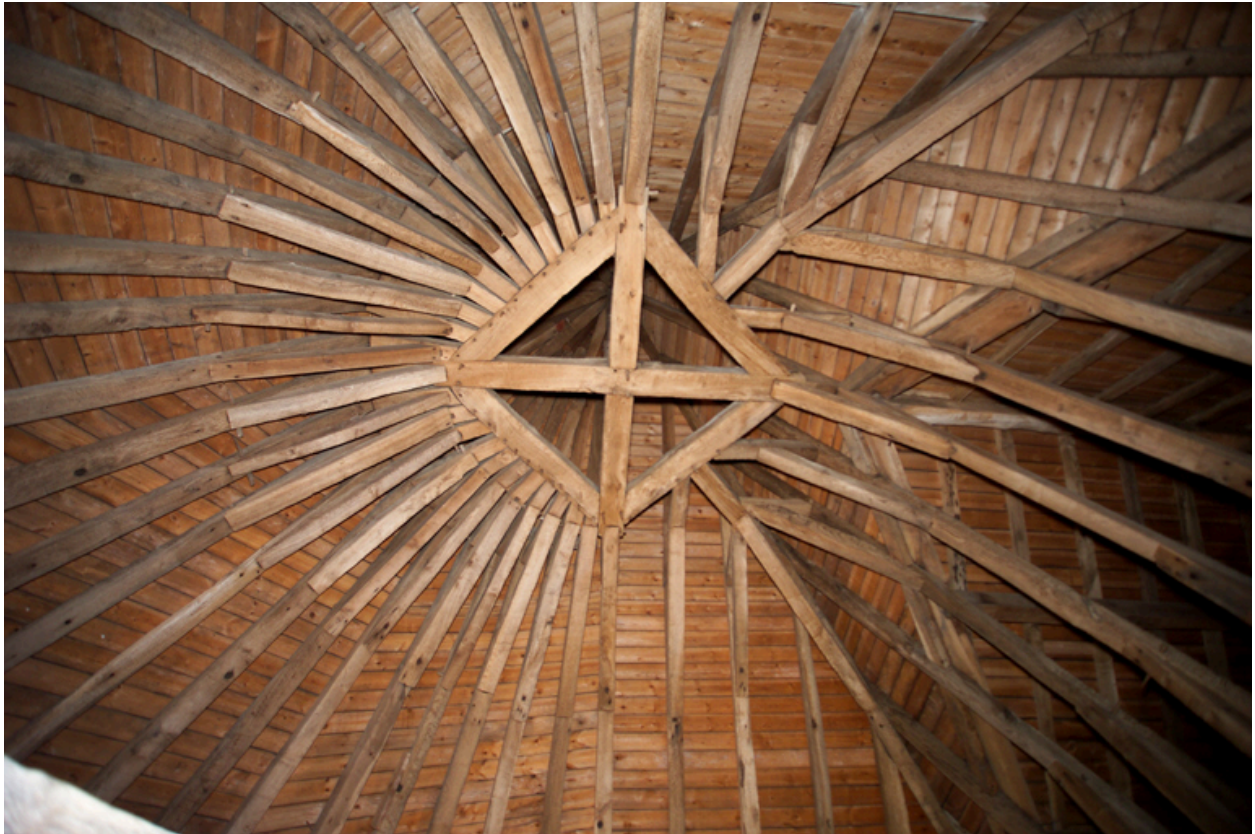
Vue de la charpente, couverture de tour.
