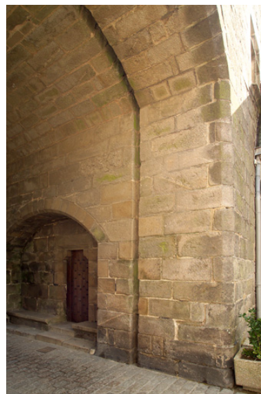
Vue du passage, détail de la feuillure de herse et de la porte ouvrant dans la tour sud. Phot. Denis Pillet IVR52_20064402084NUCA
