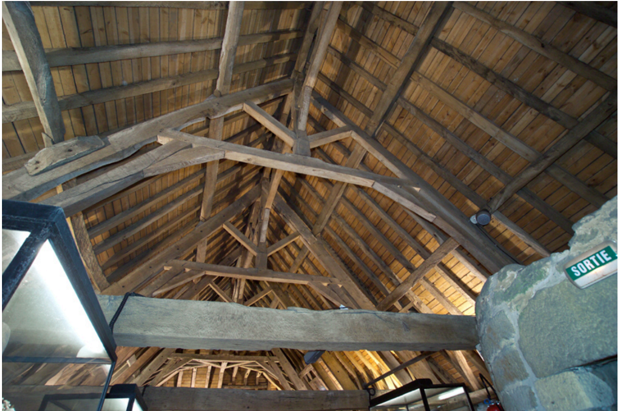
Vue de la charpente.
