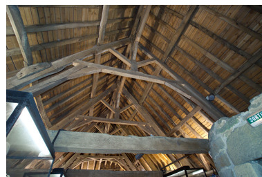
Vue de la charpente. Phot. Denis Pillet IVR52_20064401513NUCA
