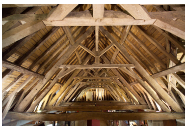
Vue de la charpente. Phot. Denis Pillet IVR52_20064401520NUCA
