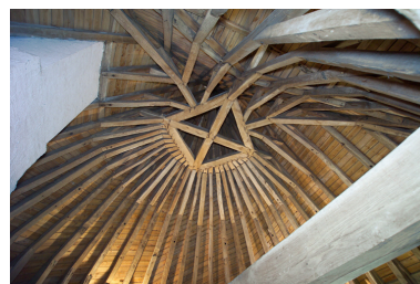
Vue de la charpente, couvrement de tour. Phot. Denis Pillet IVR52_20064401515NUCA
