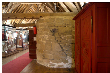
Vue du comble. Phot. Denis Pillet IVR52_20064401510NUCA
