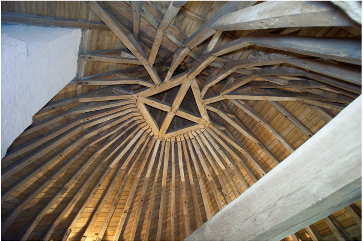
Vue de la charpente, couverture de tour.
