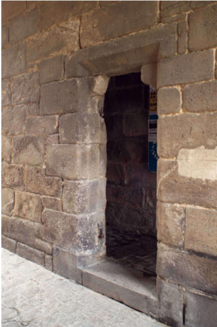
Vue du passage, détail de l'accès piéton.
