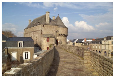
Vue depuis le chemin de ronde. Phot. Denis Pillet IVR52_20064402138NUCA
