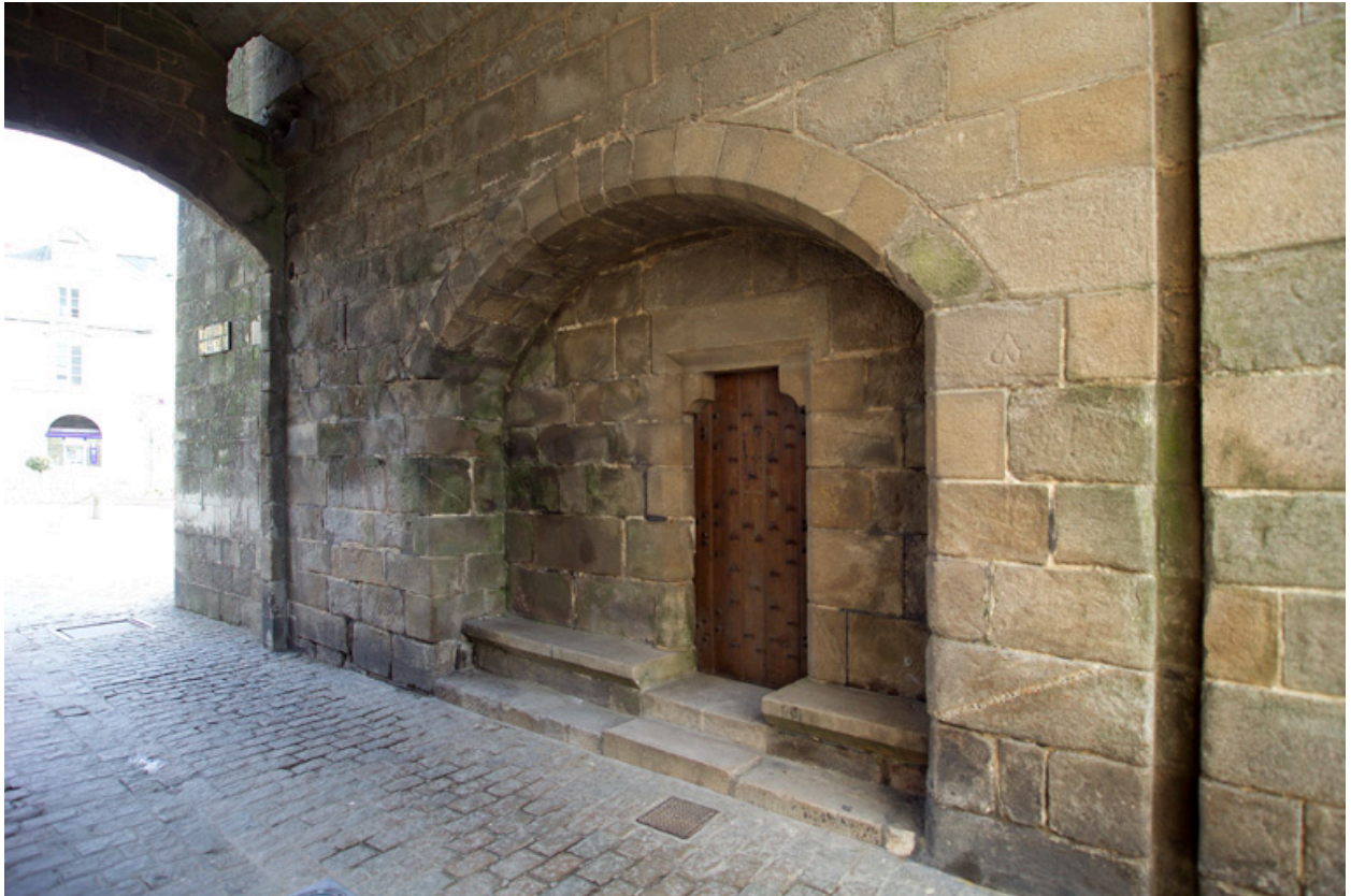
Vue du passage, détail du parement sud.
