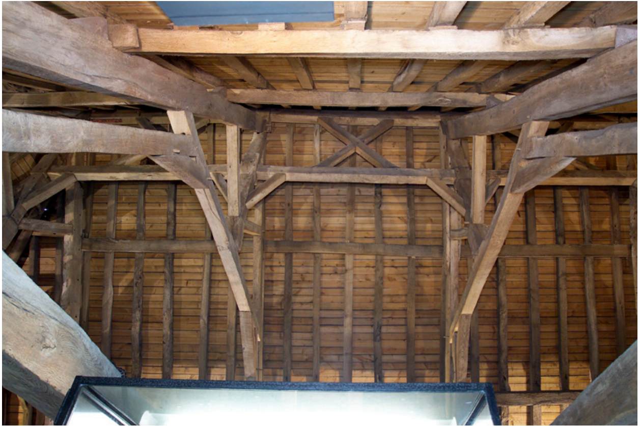
Vue de la charpente.
