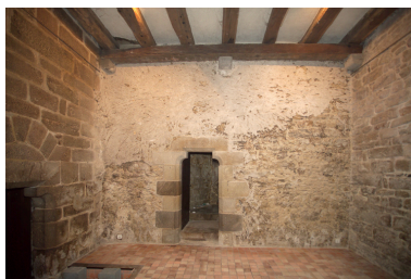
Salle au rez-de- chaussée de la tour sud. Phot. Denis Pillet IVR52_20064401541NUCA
