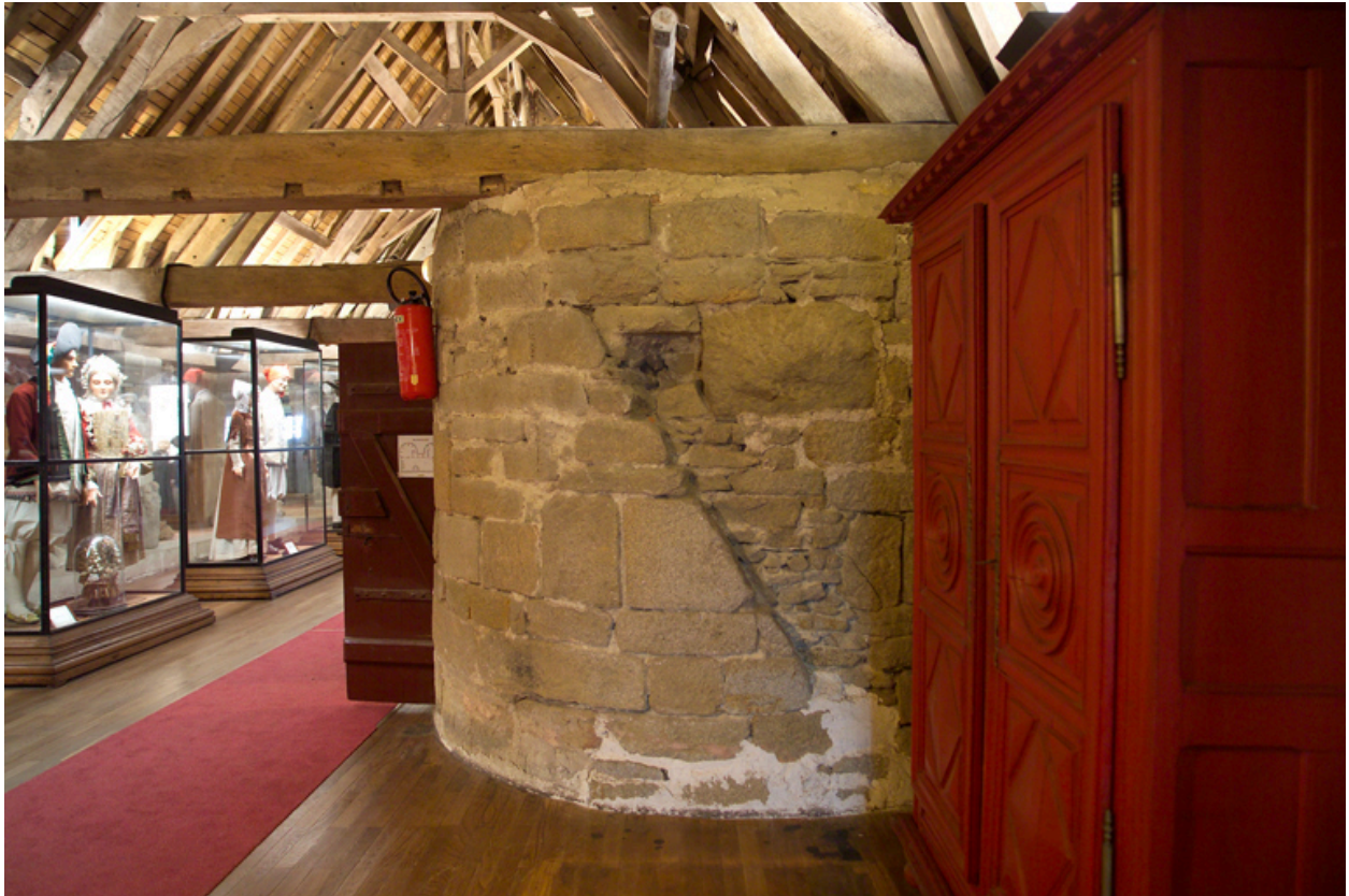
Vue du comble.
