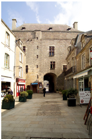
Vue de la rue Saint-Michel et du revers de la porte. Phot. Denis Pillet IVR52_20064402077NUCA
