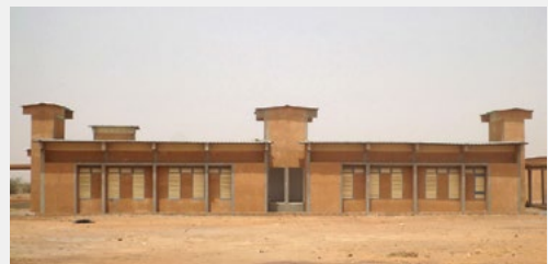
Cheminées solaires, Coopération luxembourgeoise au Niger, 2016 Source: LuxDev (2016), construction bioclimatique au Niger
