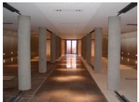
Travaux de finition du 1er étage de la salle «Forteresse et identité culturelle»
