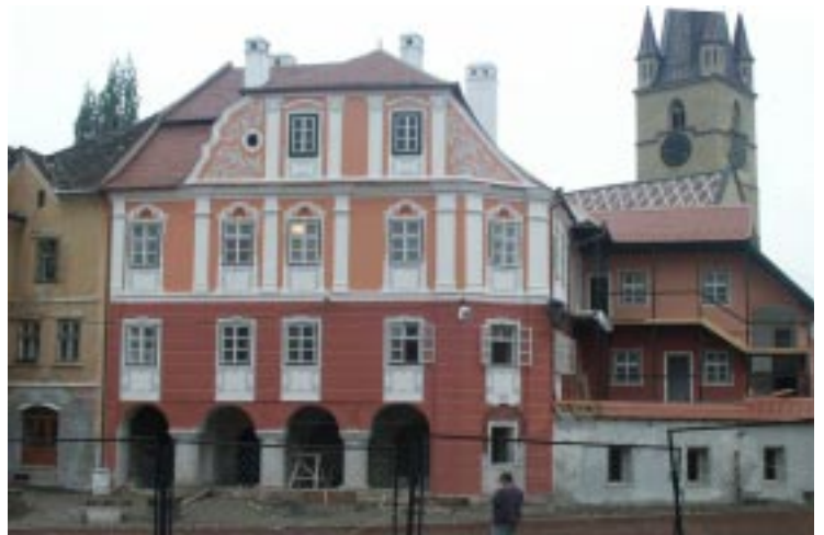
CASA LUXEMBURG (La Maison du Luxembourg) La partie gauche de la façade et l'annexe à droite s'étaient effondrées et ont été reconstruites
