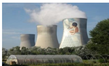
Centrale nucléaire de Cruas
