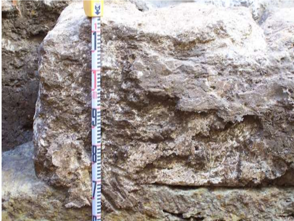
Fig.136b : Détail du stuc de la U.S. 53 (Lazaro, 2012 : lám. 65). Notons que le stuc est aussi utilisé sur les murailles comme étant un moyen de mieux protégé les sillares contre les éléments naturels
