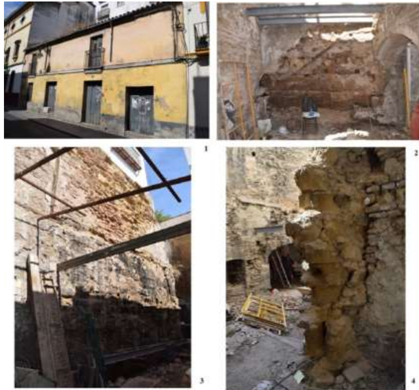
Fig.129: Restes d'une probable enceinte médiévale au n°35 de la calle Alfaro. 1-Maison actuelle, 2-détail du mur porteur à l'intérieur de la maison, côté sud; 3- détail du mur porteur, côté nord; 4-Détail de largeur du mur porteur côté nord avec un remplissage interne à base de calicastro .
