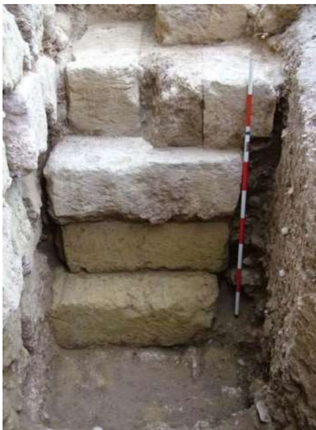
Fig.101a: Détail du mur de renfort sur la partie extramuros de la muraille ou forro (Ortiz Urbano, 2007, lám.36, foto 71)
