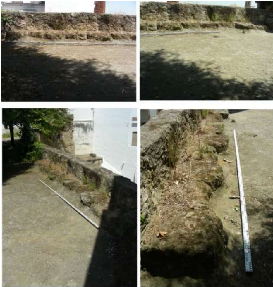
fig.121c : Rangée de blocs dans la partie supérieure de la trame dans le couvent de los Capuchinos
