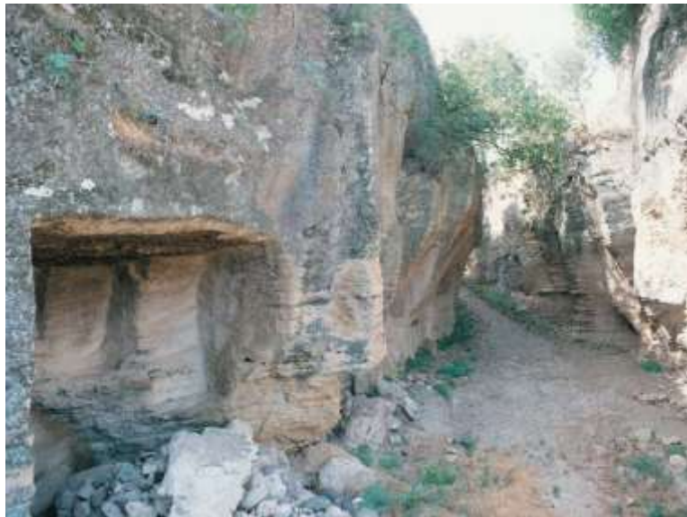
Fig.144b: Exploitation à ciel ouvert de la carrière de Santa Ana de la Albaida (photo de dessous: Vallejo, Fernández, 2010: 410 lám.3)
