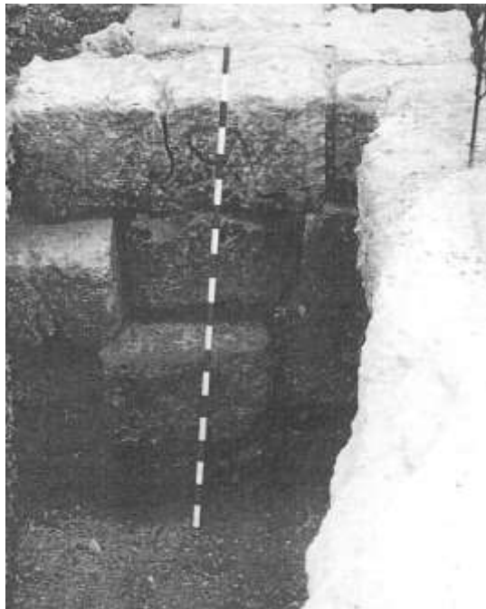
Fig.48: Parement sud-ouest de la structure C avec la marque de chantier SA (Camacho Cruz, 1999, fotografía 13)
