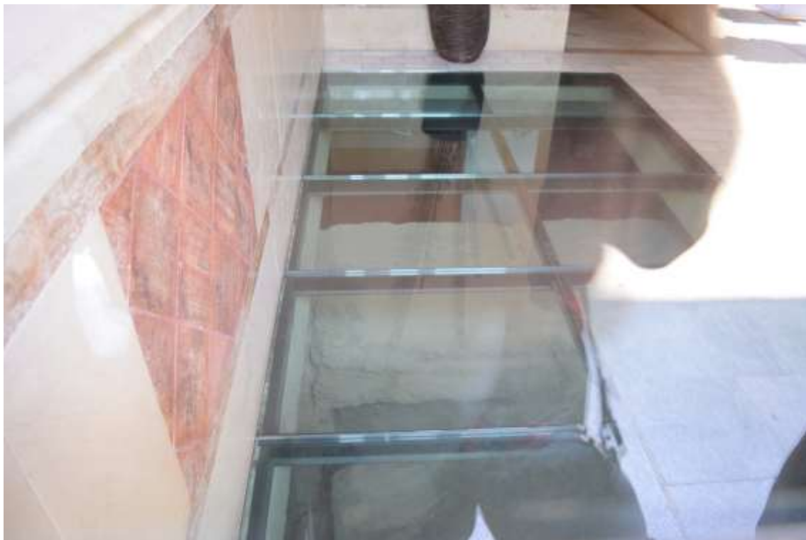
Fig.55b: Vue actuelle du site au Paseo de la Victoria n°17
