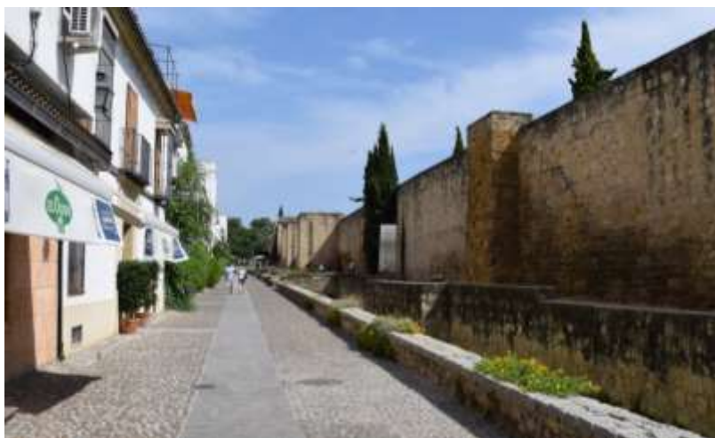
Fig.165a: Vue actuelle de la calle Cairúan
