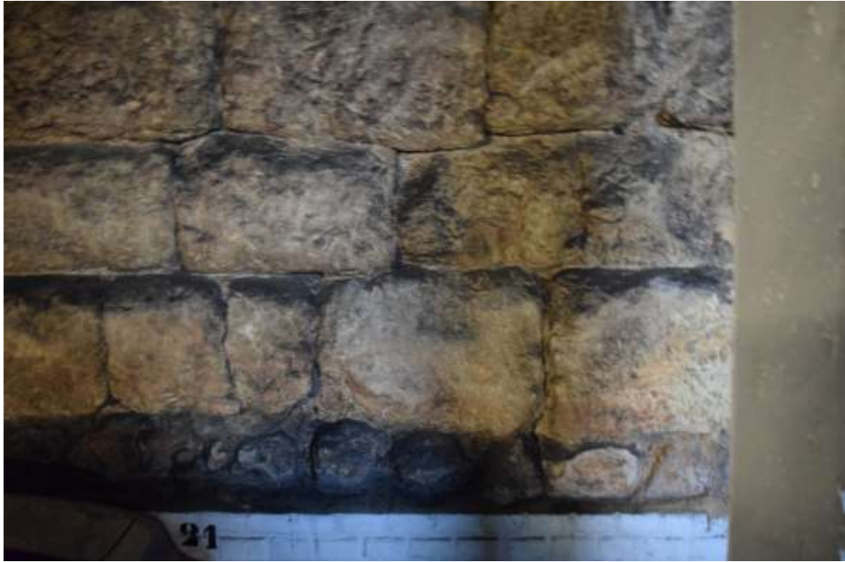
Fig.26b: Détail de la trame inférieur où il apparait des blocs retaillés offrant un caractère polygonale
