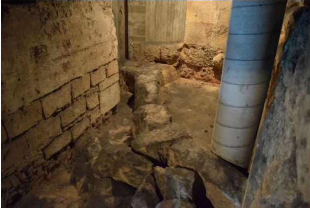
Fig.175b: Détail actuel de la tour semi-circulaire, de l'avant-mur et de la structure rectangulaire (au fond)
