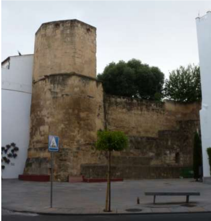
Fig.6b: La Torre del Rincón de nos jours
