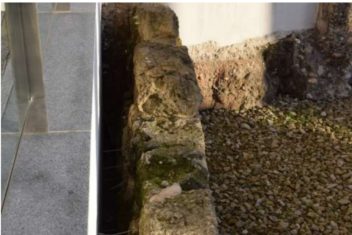
Fig.80c: Vision intramuros du mur de contention avec le détail de blocs à bossage
