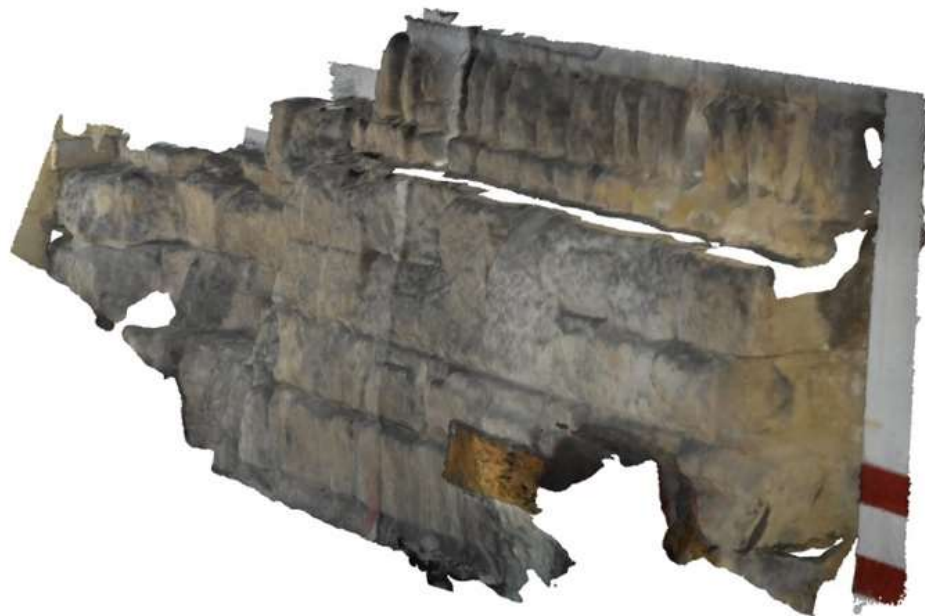
Fig.170: Panse / forro à Plaza de Colón n°8 (en haut) et Plaza de Colón n°9 (en bas)
