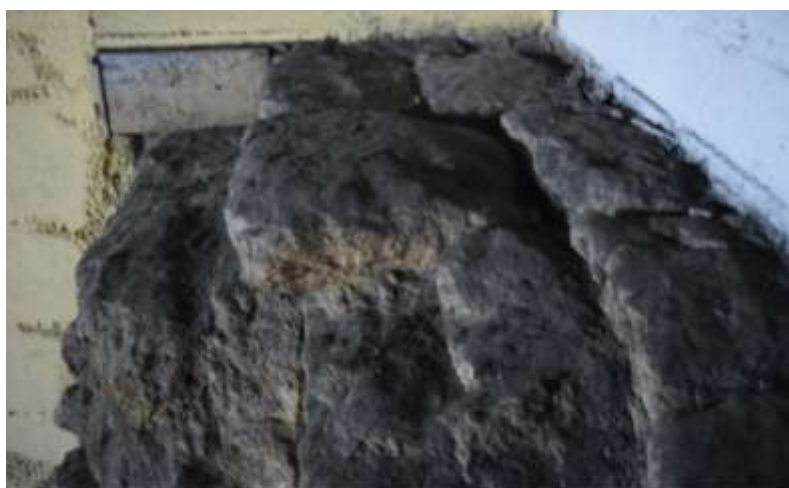
Fig.27a: Détail du décalage et de la mise à niveau pour la réforme d'époque islamique
