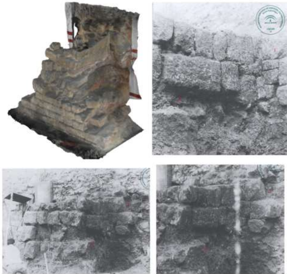
Fig.171: Relation de la tour (2) avec la trame (1) à Plaza de Colón n°9. Pour la fabrication nous pensons qu'il s'agit du forro . (Photos en noir et blanc ont été facilitées par le Museo Arqueológico de Córdoba , caja 433)
