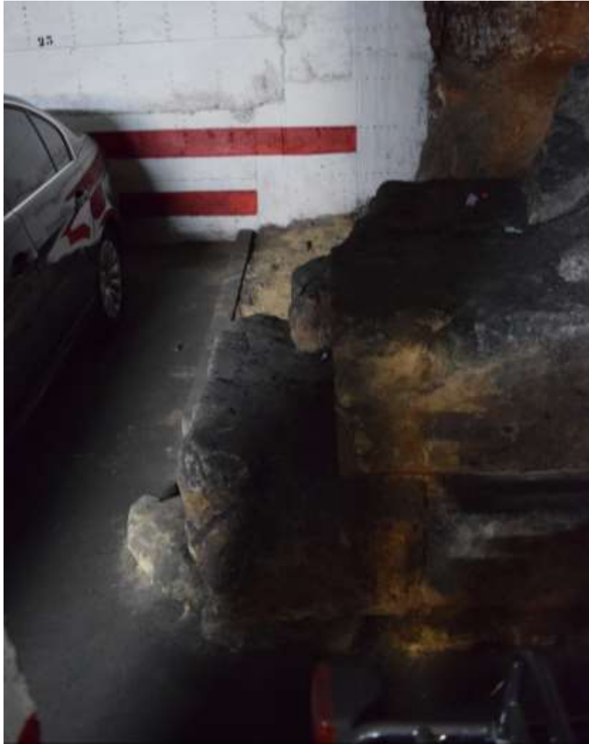
Fig.24c: État actuel de la tour rectangulaire. Notons la suie qui s'y ait déposé
