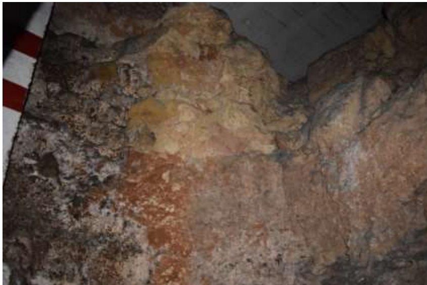
Fig.24d: Détail du coeur de la tour rectangulaire
