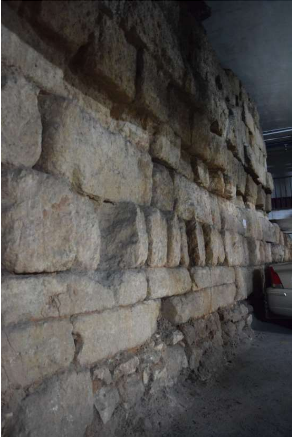
Fig.38: Détail des parois de la muraille intramuros
