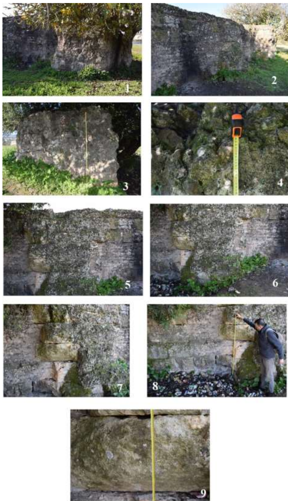
Fig.151e: La citerne et les contreforts. (De haut en bas, de gauche à droite) Vision de la citerne avec les contreforts (1,2), profil de la courtine et du contrefort (3) avec un détail des blocs (4), détail d'un contrefort (5 à 9)
