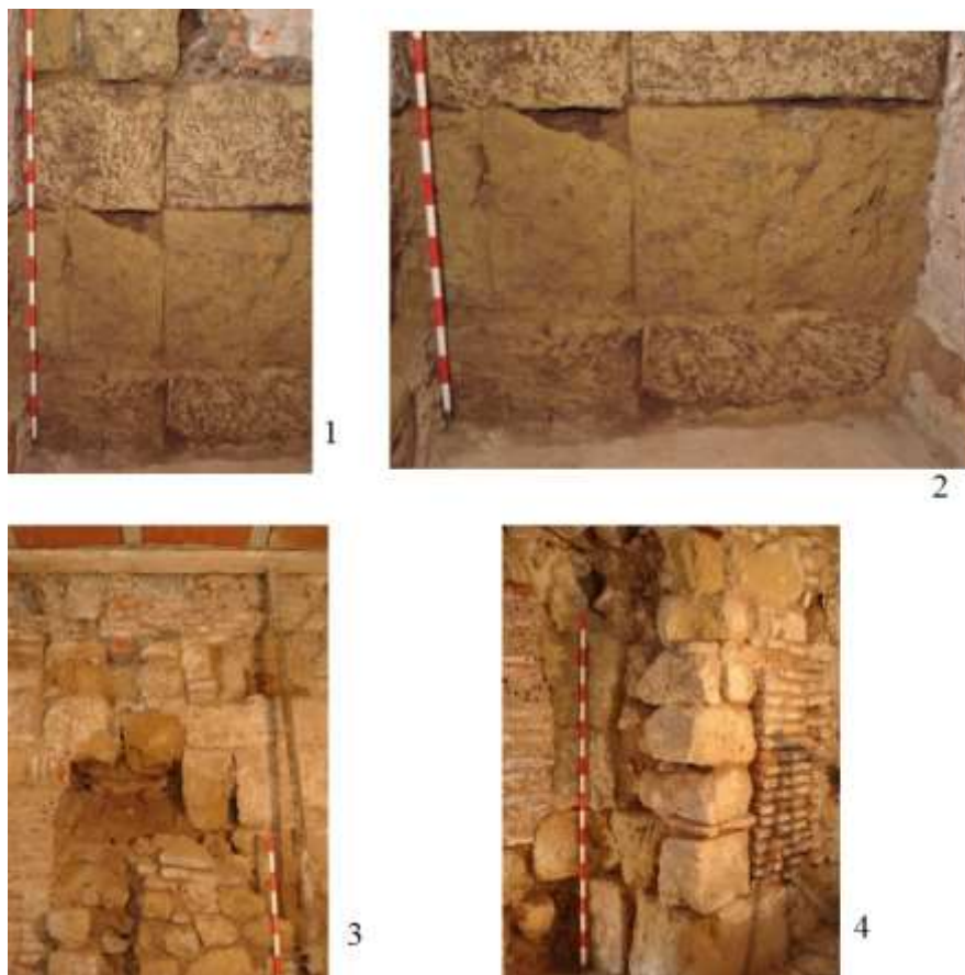
Fig.87: Photos sur les restes de la muraille romaine intégrée dans l'immeuble n°122 (Jurado Martínez, 2009: lám.4, 5, 6, 17). 1- Unités stratigraphiques 1 et 5, opus quadratum , immeuble n°122; 2- Détail des bocs de pierre d'époque romaine, immeuble n°122; 3- Détail de la détérioration de la muraille romaine; 4- Détail du coin de la salle de bain où se situe des restes de la muraille romaine, immeuble n°122
