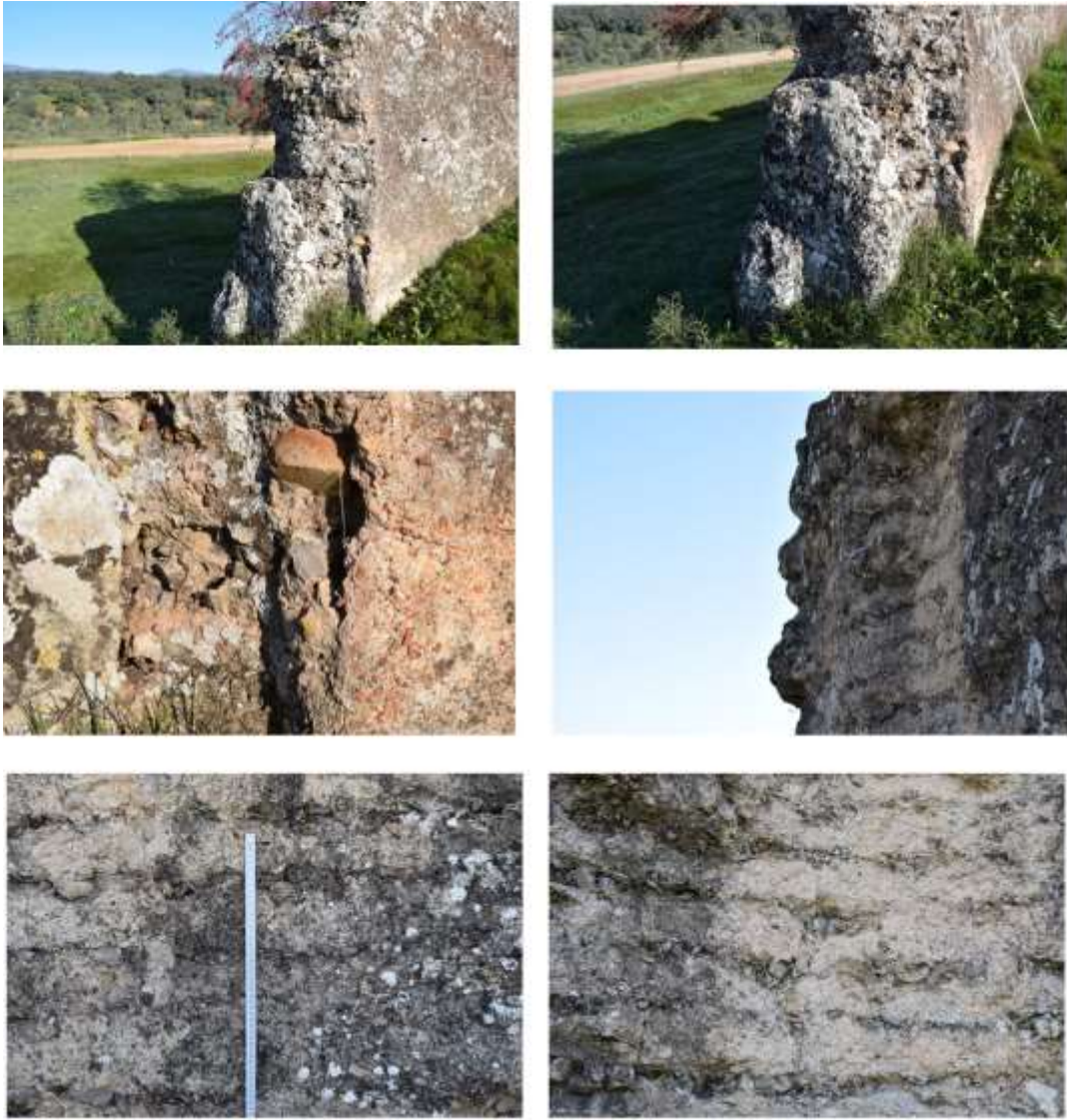
Fig.151c: Opus caementicium de la citerne (noyau et partie externe)
