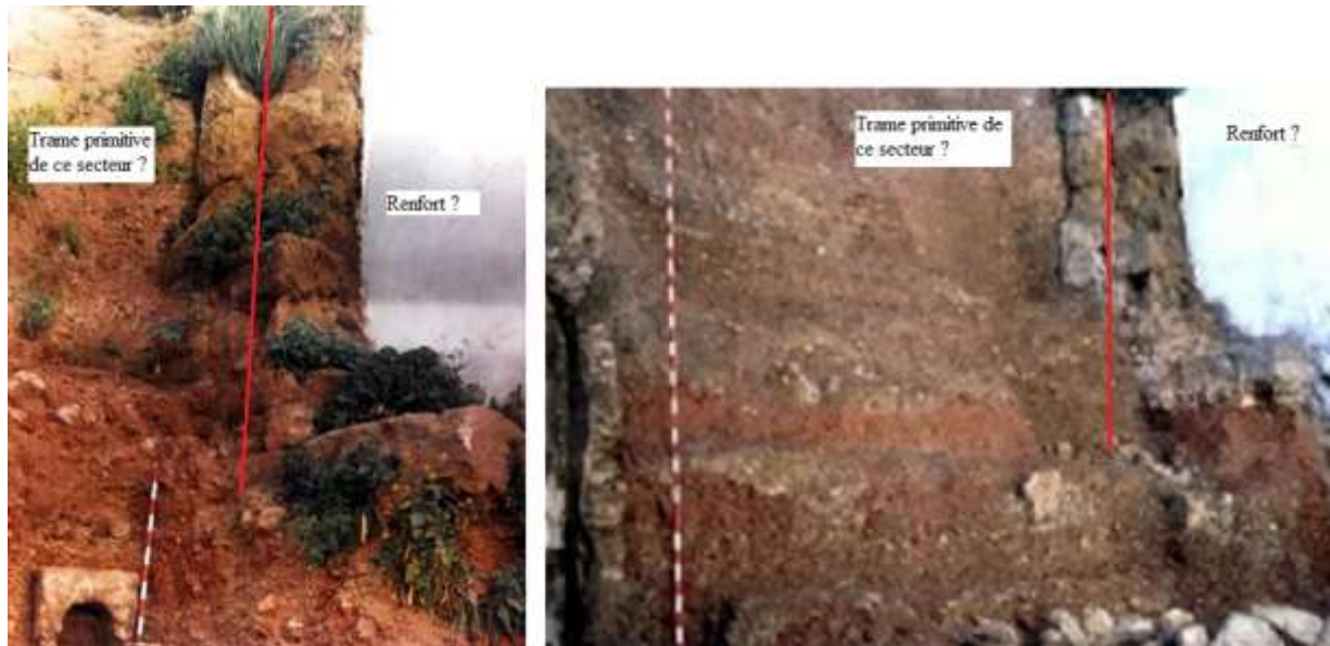
Fig.186: Présence d'un renfort dans la calle Puerta del Rincón n°3?
