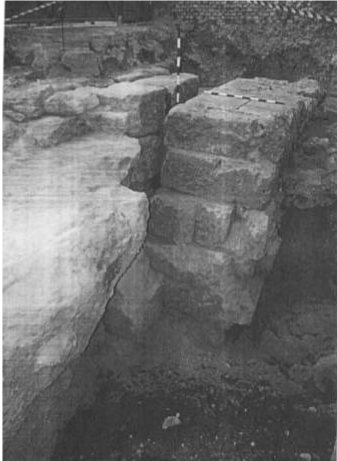
Fig.47: Structure B qui s'incline (Camacho Cruz, 1999, fotografía 5)
