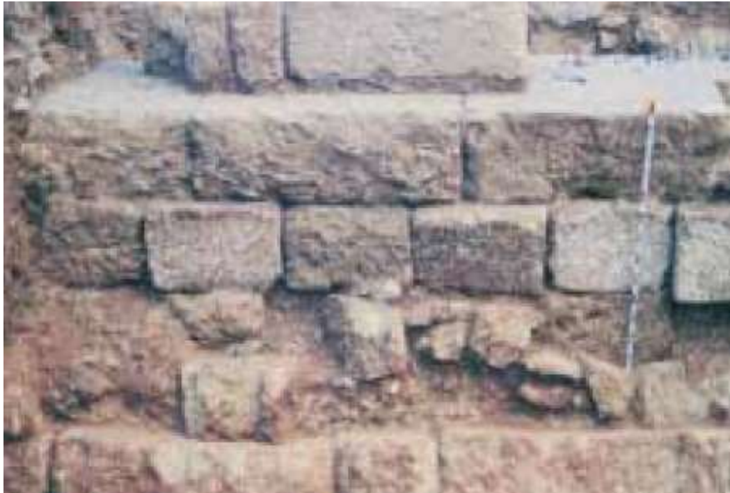
Fig.52b: Détail du parement interne de la muraille du Paseo de la Victoria n°17 (Ruiz Nieto, 2003: 478, lám. III)
