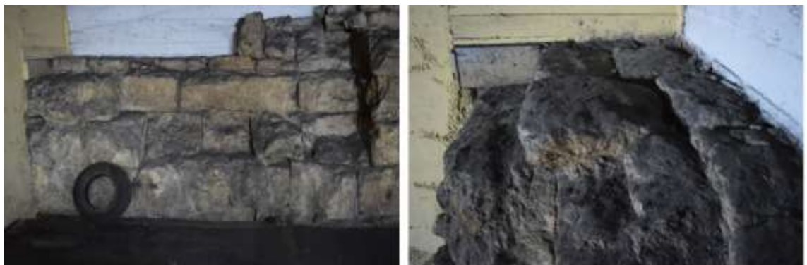
Fig.194: Préparation pour l'installation de blocs islamiques
