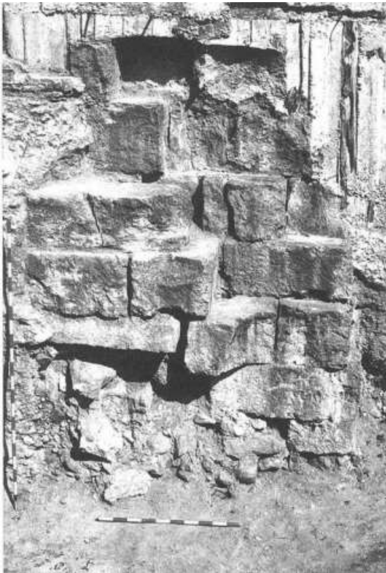
Fig.79b: Pavement externe de la muraille (Jiménez, Ruiz, 1994: 150, lám II.)
