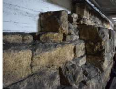
Détail de la partie supérieure Notons le décalage entre la trame islamique et la largeur du renfort
