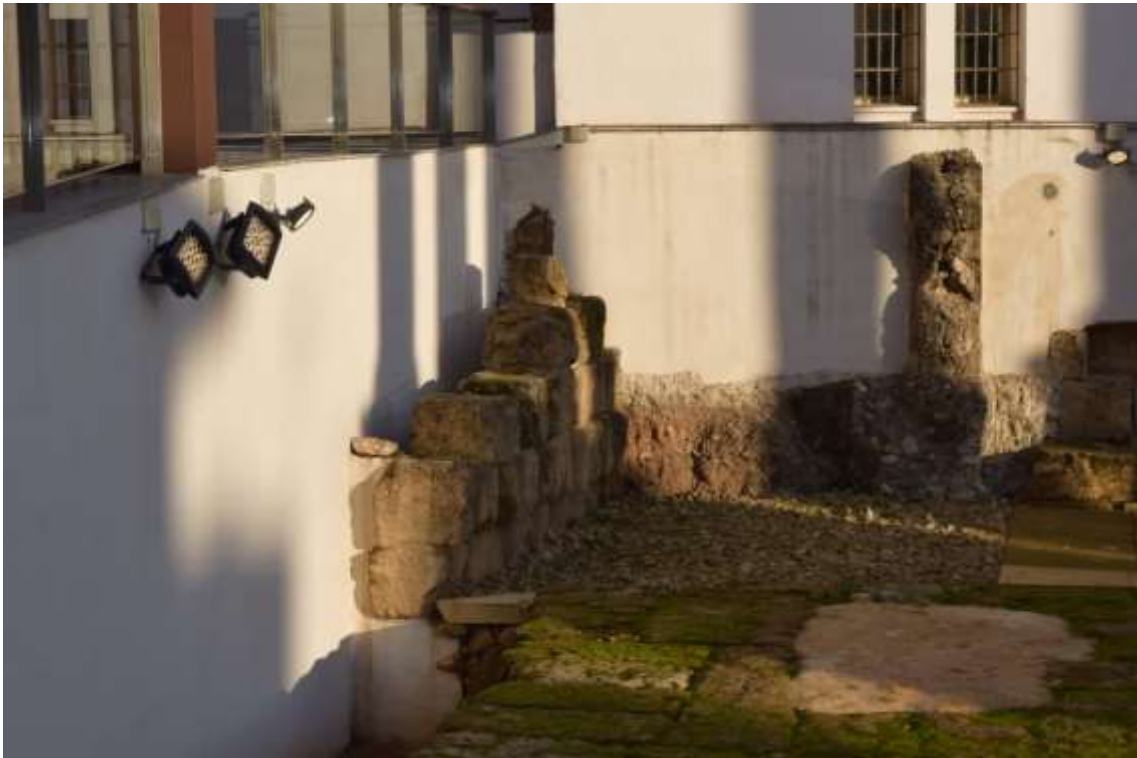
Fig.80b: Vision du parement extramuros du mur de contention de l'agger
