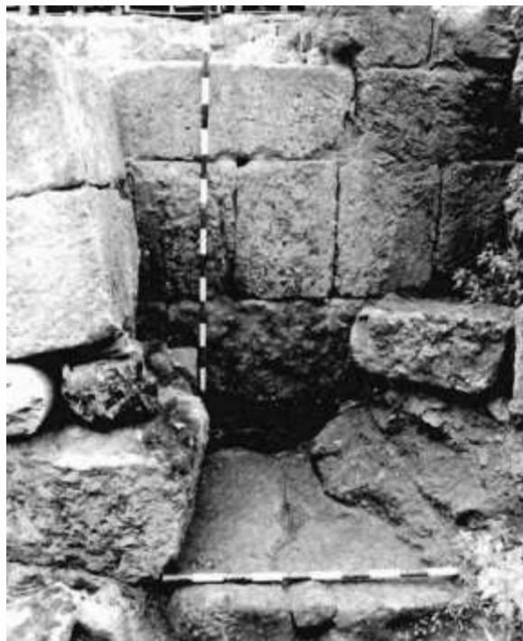
Fig.91c: Détail du parement interne de la muraille romaine (Montejo, Garriguet, 1994: 273 lám 4)
