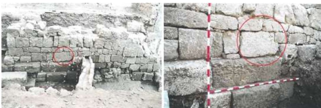
Fig.182: Détail d'une pierre apparemment retailée
