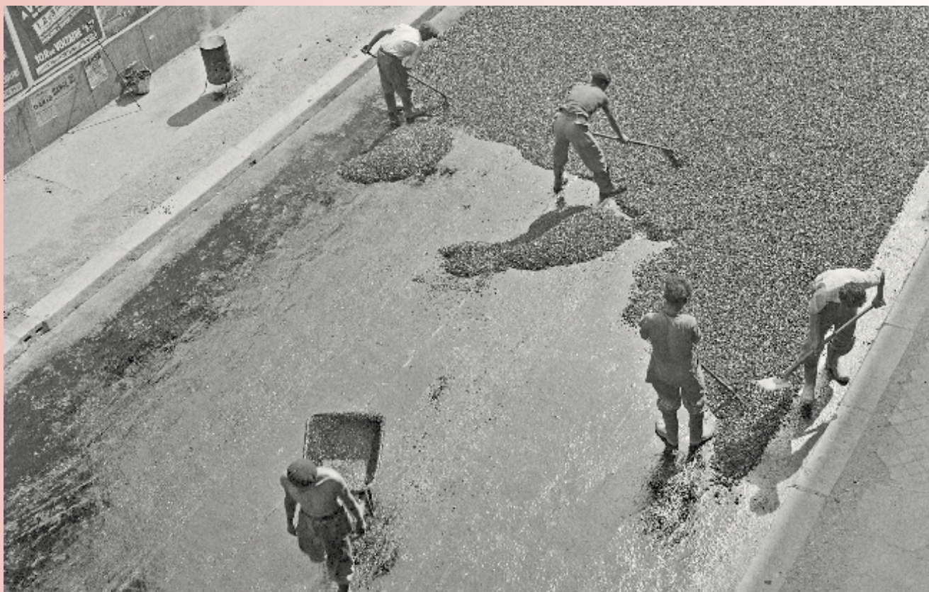
Réfection de la chaussée de la rue Froment [avant 1950]. Fonds Maurice Bertrand © Archives de Paris
