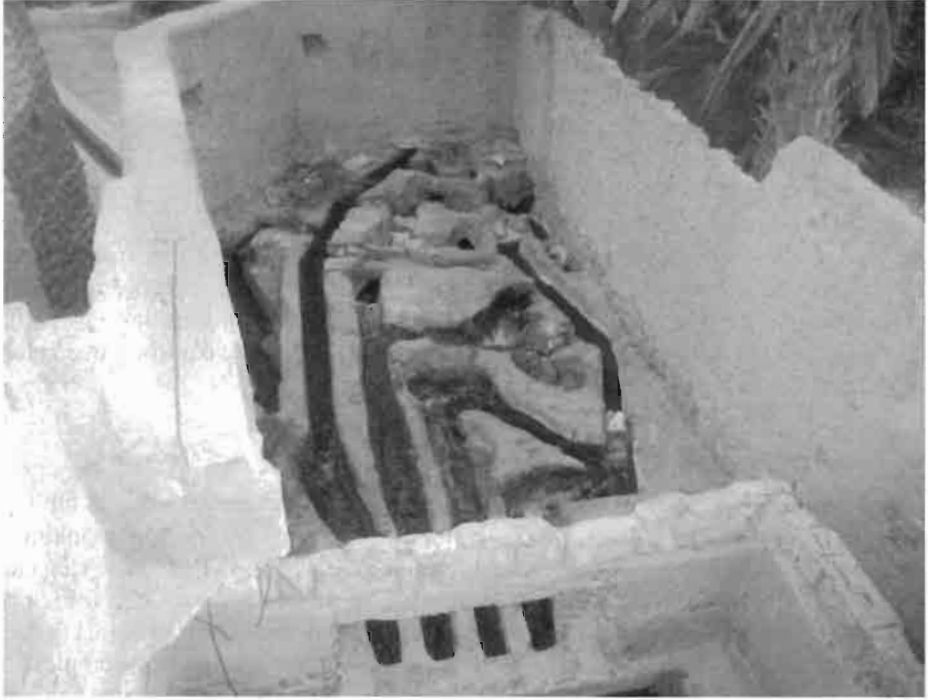
Figure 5 – Le répartiteur principal de la source Tzaddert à Zenaga
