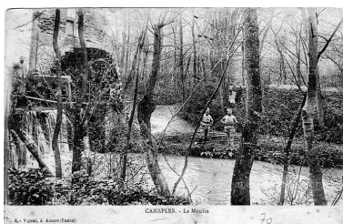
Vue du moulin avec deux soldats, 1914-1918 (AD Somme ; 8 Fi 5460). Phot. Archives départementales de la Somme (reproduction) IVR22_20108001012NUCA
