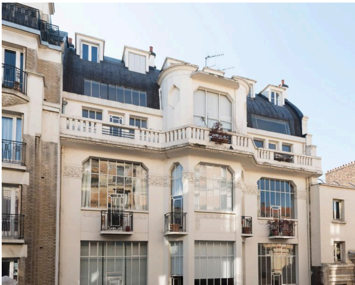
Vue des derniers étages de la façade sur rue
