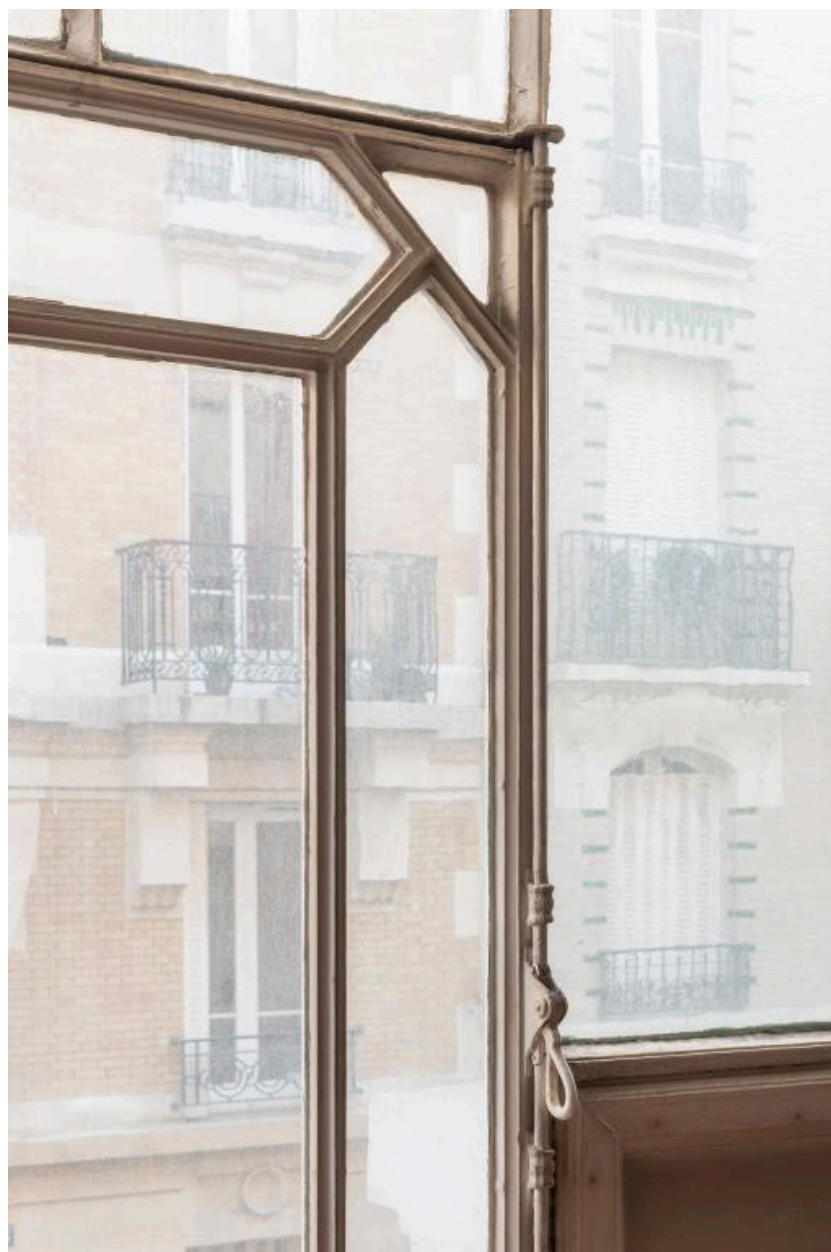
Détail de la verrière de l'atelier du premier étage donnant sur rue
