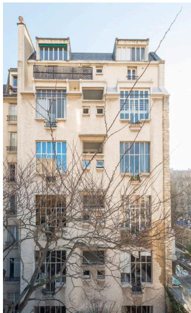
Vue de la façade de l'immeuble sur cour, depuis le premier étage de l'immeuble lui faisant face Phot. Philippe Ayrault IVR11_20197500191NUC4A
