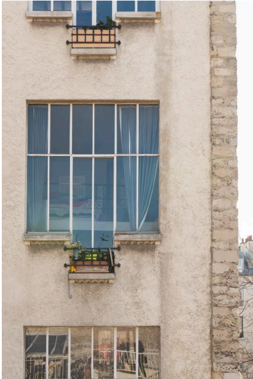
Détail d'une des verrières du quatrième étage de la façade sur cour
