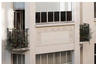
Détail de la frise décorative et des balconnets du deuxième étage de la façade sur rue Phot. Philippe Ayrault IVR11_20197500187NUC4A
