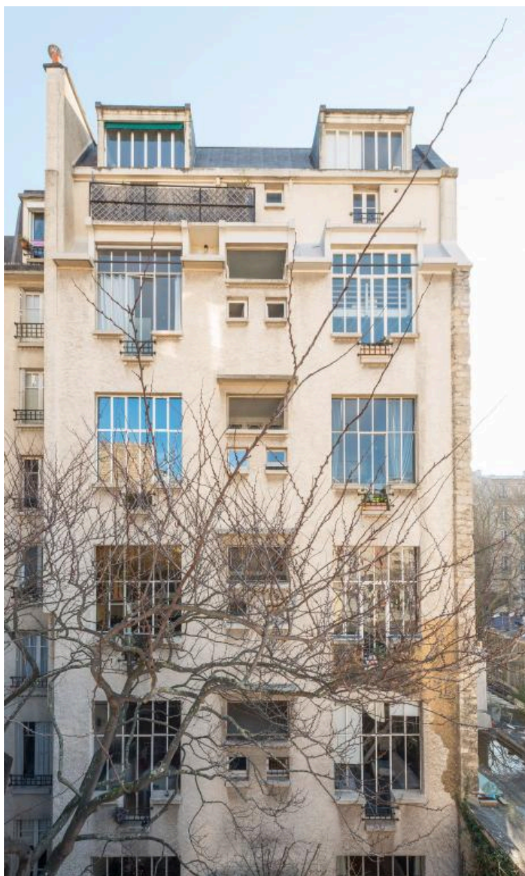
Vue de la façade de l'immeuble sur cour, depuis le premier étage de l'immeuble lui faisant face
