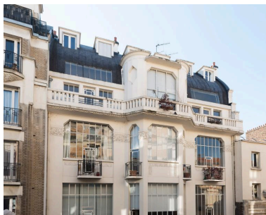
Vue des derniers étages de la façade sur rue Phot. Philippe Ayrault IVR11_20197500185NUC4A
