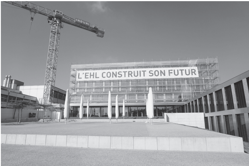
Figure 1 Chantier de l'EHL
