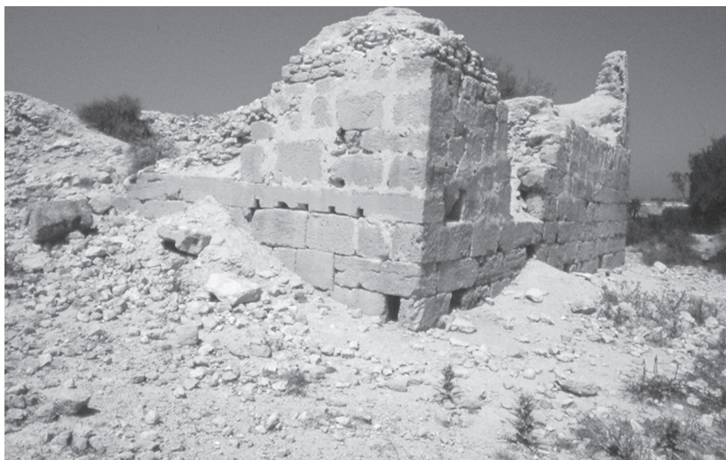
Fig. 12: Gasr Silin 19: montanti di torcular riusati nella muratura del gasr .
