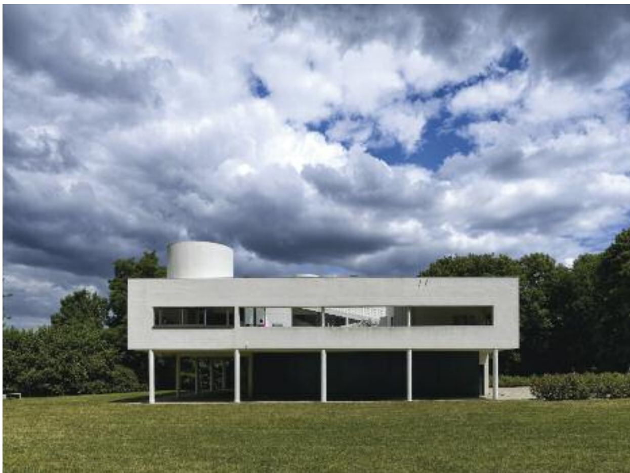
Villa Savoye, façade sud. Le principe de la pureté de la forme primaire atteint ici son expression la plus accomplie avec la répétition des façades identiques. Ph. Cemal Emden, 2014.
