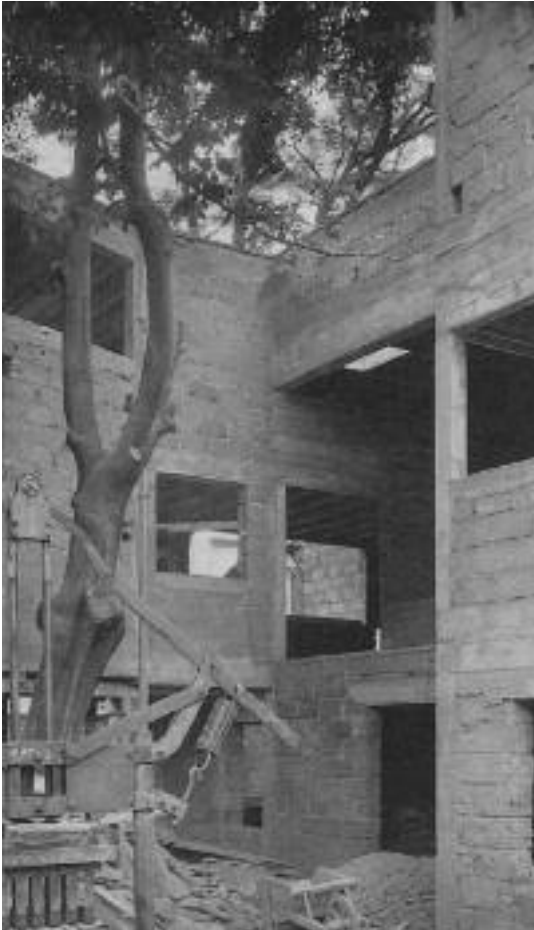
Chantier de la maison La Roche et Jeanneret, vue sur la grande baie (façade nord est), 1925. « L'Architecture vivante », automne MCMXXVI, édition Albert Morancé, Paris 1926.
