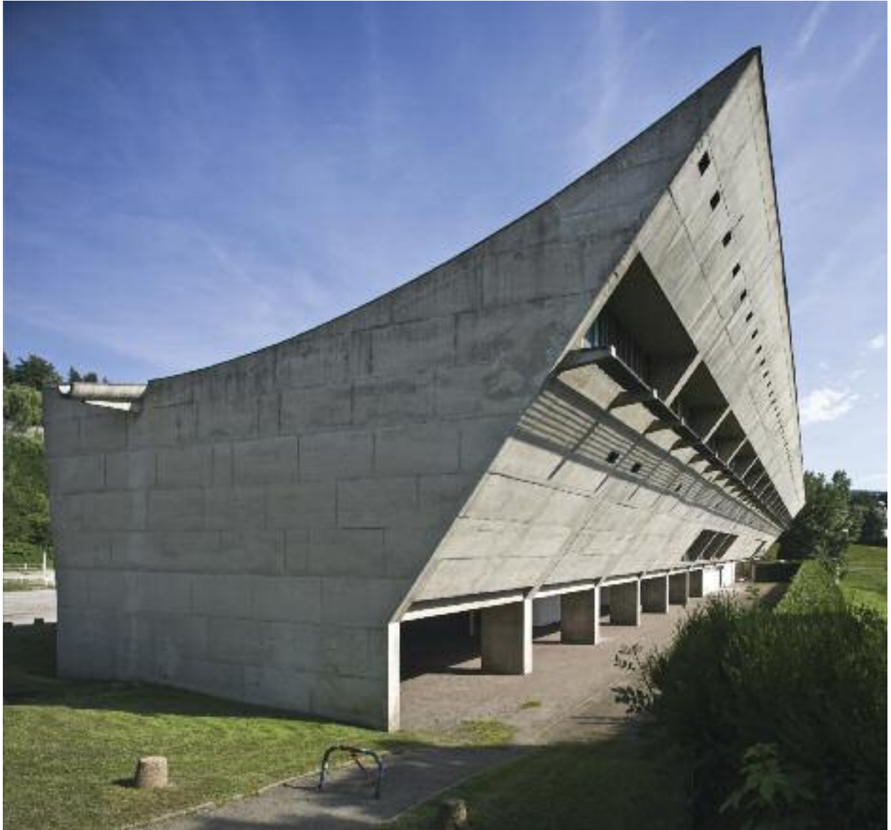
Maison de la Culture de Firminy. Façade ouest. L'effet produit par l'inclinaison de la façade est amplifié par la falaise qu'elle surplombe. La courbe de la toiture épouse exactement celle des câbles d'acier qui la supportent. Ph. Olivier Martin-Gambier, 2008.
