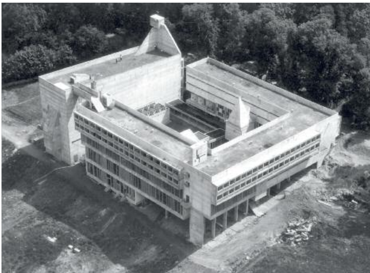
Couvent Sainte-Marie-de-la-Tourette, Éveux. Vue de la façade sud du Couvent (Ph. Cemal Emden) et vue aérienne : au nord le bloc compact de l'église, à l'est l'aile d'entrée, à l'ouest l'aile du réfectoire et des salles communes. Les cellules sont réparties sur trois côtés : à l'est, au sud et à l'ouest. Archives FLC
