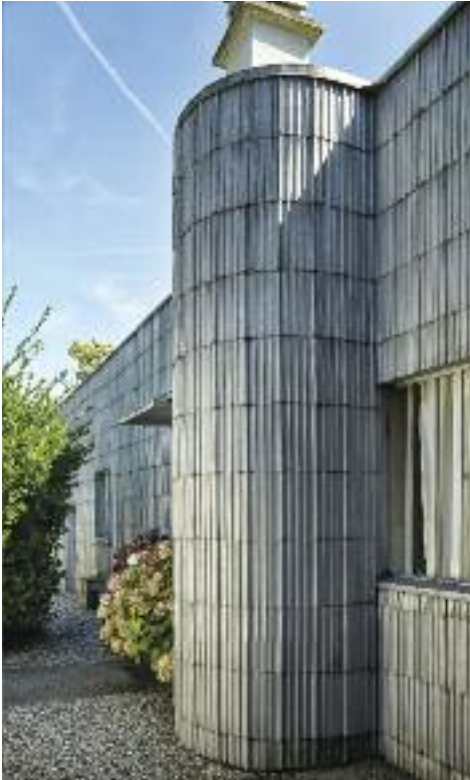
Détail de la façade nord avec le bardage métallique posé en 1931. Ph. Cemal Emden, 2012.
