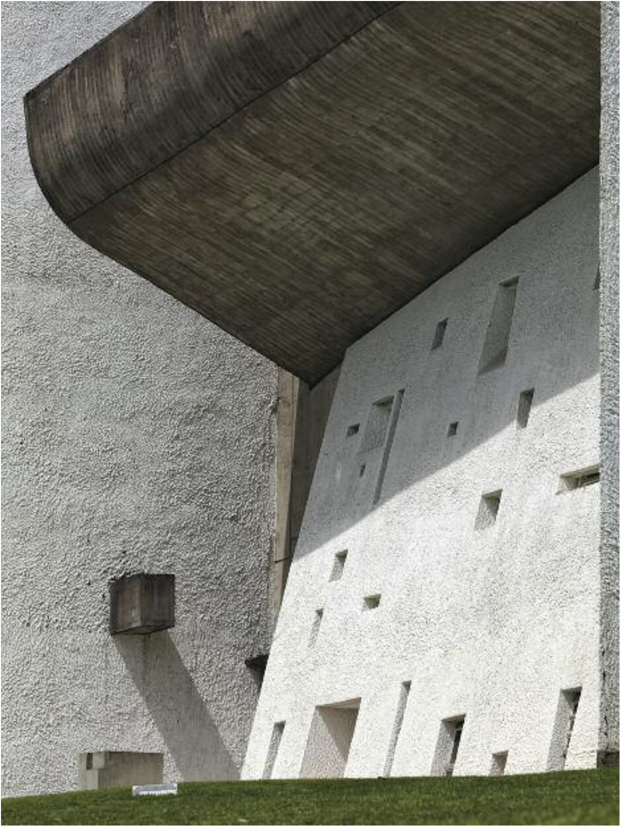
Chapelle Notre-Dame-du-Haut, détail de la façade de l'entrée principale au sud illustrant la dimension sculpturale de la composition volumétrique de la chapelle. Ph. Cemal Emden, 2013.
