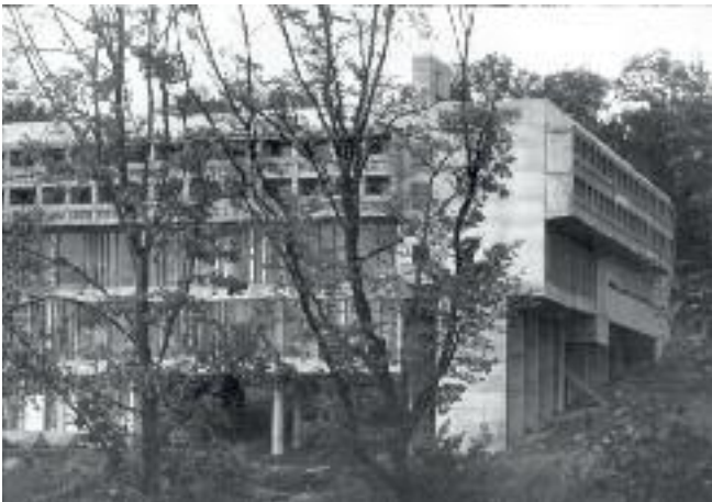
Vue partielle des façades ouest et sud. Les pilotis en forme de voiles permettent d'absorber la déclivité du site et de rétablir une assiette horizontale. Archives FLC
