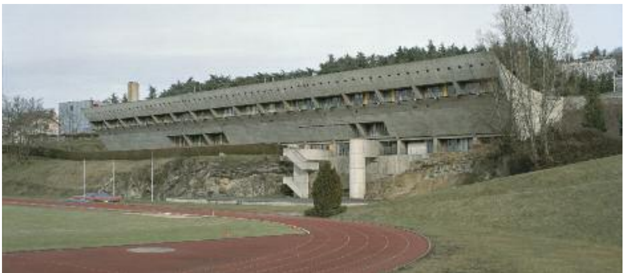
Maison de la Culture de Firminy. Façade ouest : la Maison de la Culture domine l'ancienne carrière où est implanté le stade. Deux escaliers monumentaux relient le petit foyer à un théâtre en plein air dont les gradins sont creusés dans la pente du terrain. Ph. Olivier Martin-Gambier, 2008.
