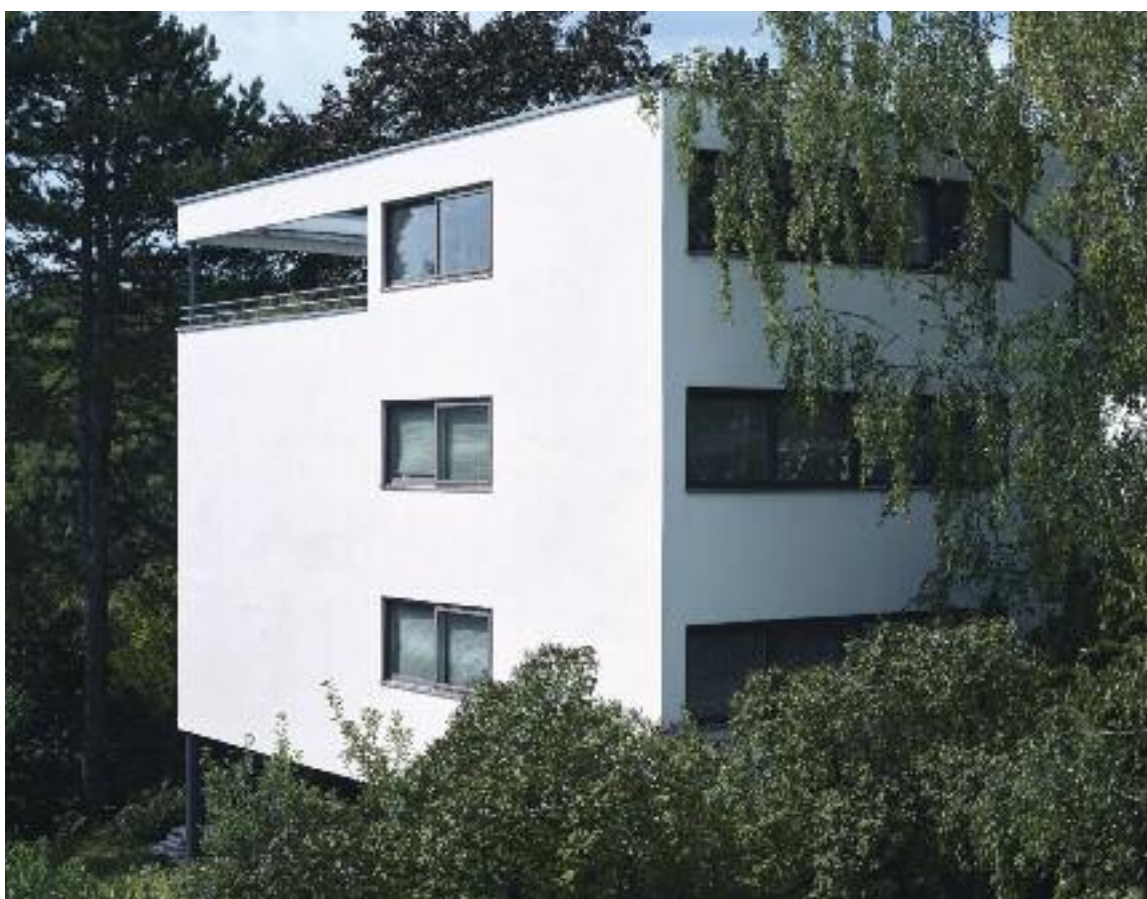
Maisons de la Weissenhof-Siedlung, Stuttgart. En haut : les Maisons jumelées ; en bas : la Maison individuelle, application exacte du modèle Citrohan. Ph. Cemal Emden, 2013.
