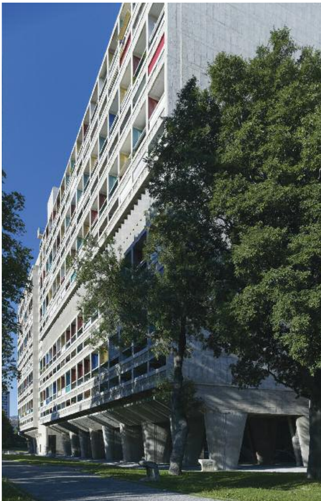
Unité d'habitation, Marseille. Monumentalité affirmée, effets de béton brut de décoffrage, polychromie franche : la Cité radieuse est un chef d'œuvre précoce et fondateur du courant brutaliste. Ph. Cemal Emden, 2013.
