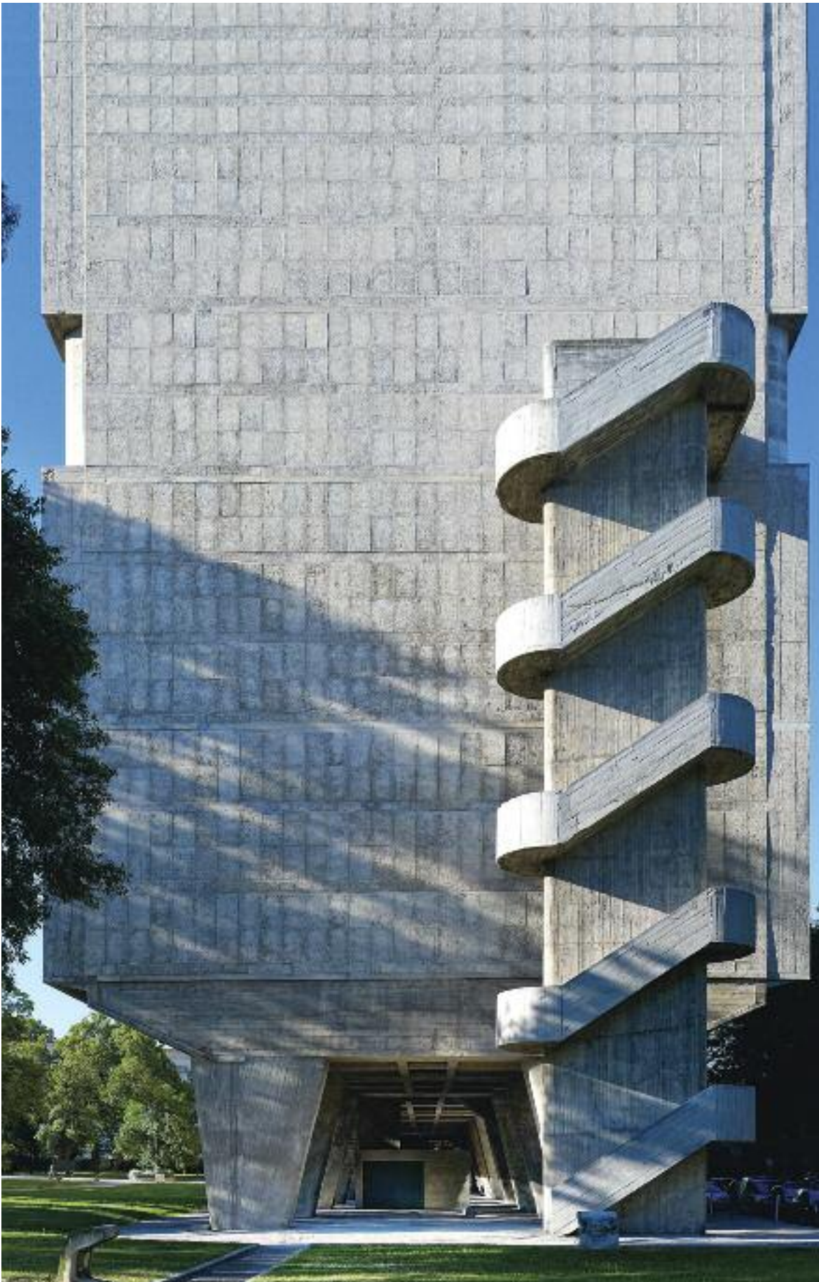
Unité d'habitation, Marseille. Escalier de secours extérieur et d'accès à la rue commerçante de l'édifice. Ph. Cemal Emdel, 2013.
