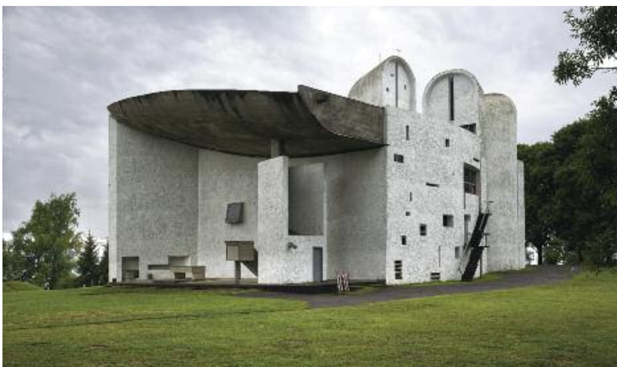
Chapelle Notre-Dame-du-Haut, Ronchamp. Façades nord et est de la chapelle.
