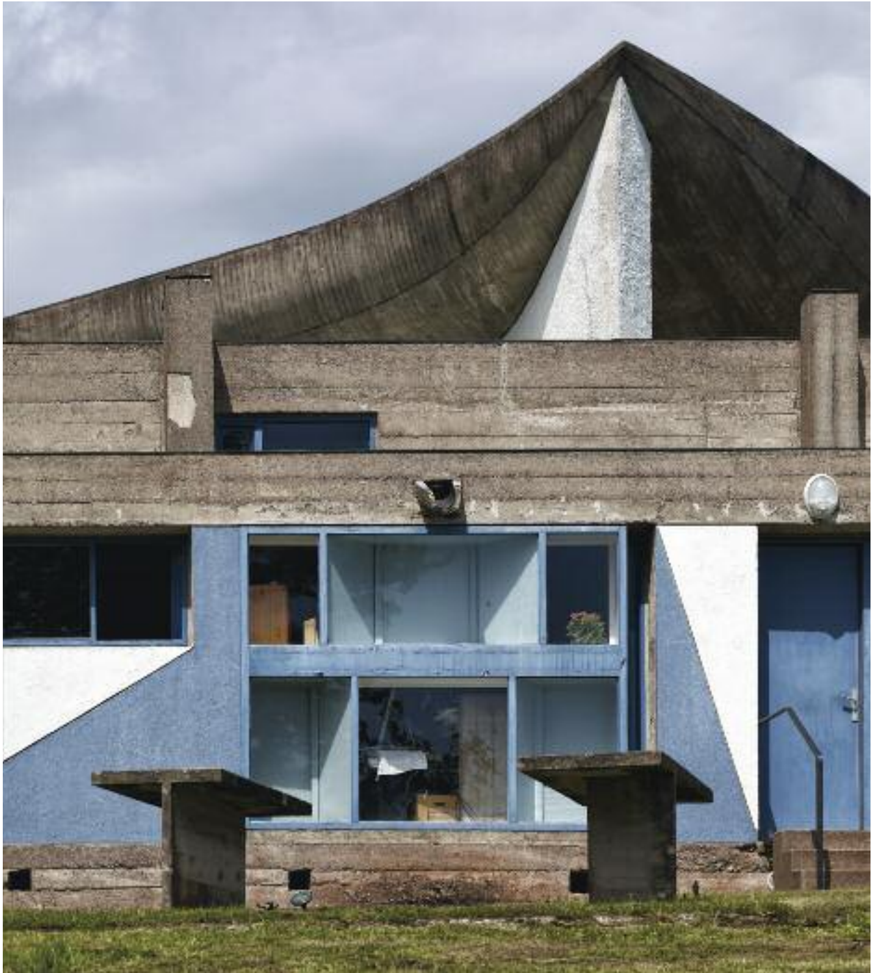
Chapelle Notre-Dame-du-Haut, Ronchamp. Les formes rectilignes de la maison des pèlerins – au premier plan – se combinent avec les courbes sculpturales de la toiture de la chapelle. Ph. Cemal Emden, 2013.
