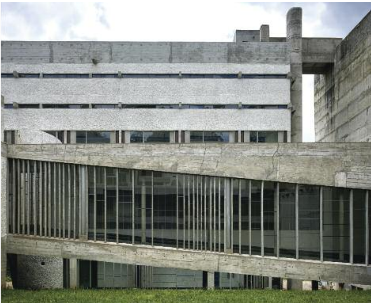
Dans la cour intérieure, détail de la galerie en forme de croix qui se substitue au déambulatoire. Les branches, baptisées grand ou petit « conduits » sont éclairées par des pans ondulatoires mis au point par Iannis Xénakis. Ph. Cemal Emden, 2013.
