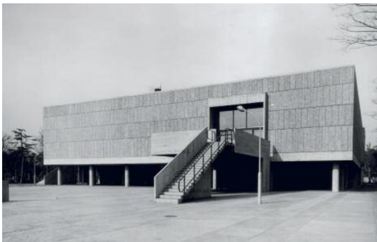
Musée National des Beaux-Arts de l'Occident Taito-Ku, Tokyo. Façade principale de l'entrée du musée, récente (2007) et ancienne, qui montre le haut degré d'authenticité et d'intégrité de l'édifice.
