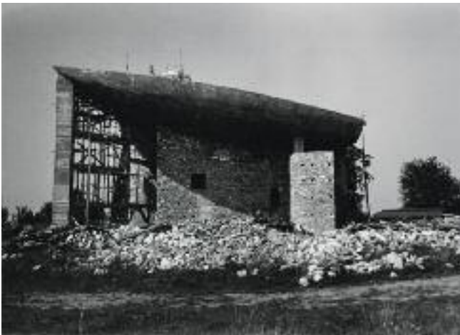
Ci-dessus : vue du chantier montrant l'ossature de béton et le remplissage exécuté avec les pierres de l'ancienne chapelle détruite lors des combats de la Seconde Guerre mondiale. Les murs ont ensuite été recouverts d'un enduit rugueux projeté au canon à ciment. Archives FLC
