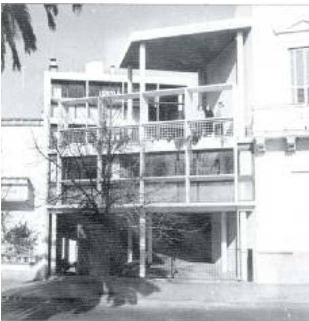
Toute la maison décline des solutions originales pour créer une relation exceptionnellement riche entre intérieur et extérieur : pilotis, rampe, jardin intégré à la construction, brise-soleil, terrasse en partie couverte, vastes baies vitrées. L'ensemble réinterprète les canons puristes des années vingt en les adaptant aux conditions locales de l'Argentine. Ph. Olivier Martin-Gambier, 2005. Ph NB : archives FLC.
