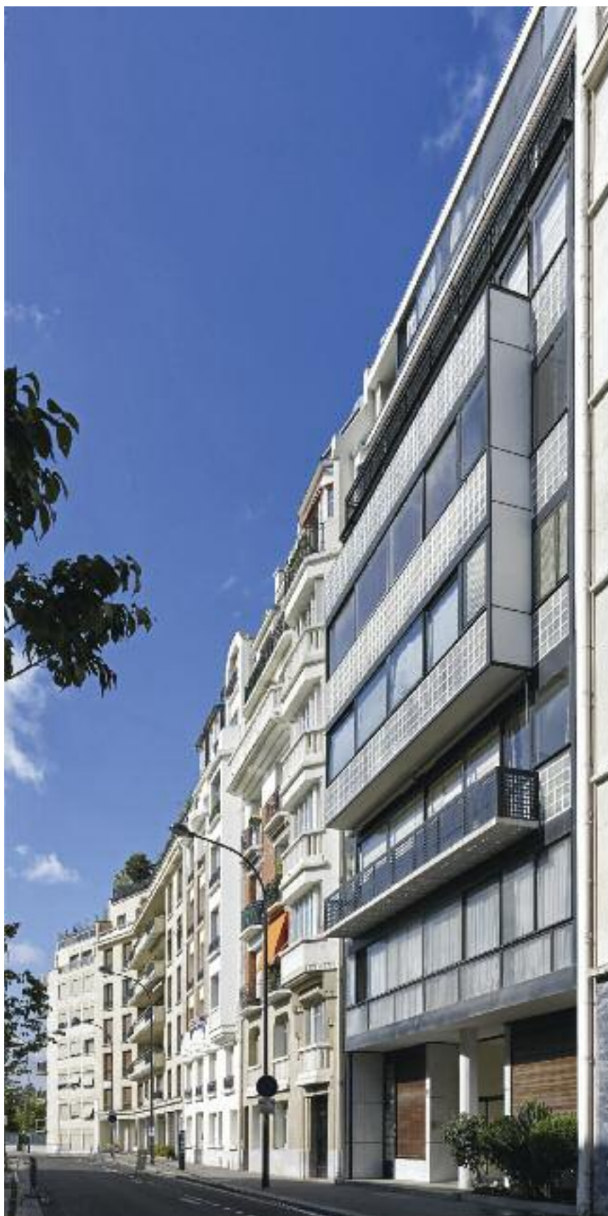
Immeuble locatif à la Porte Molitor, Boulogne-Billancourt. Façade principale, entièrement en verre, ouverte sur la ville de Paris. Ph. Cemal Emden, 2014.
