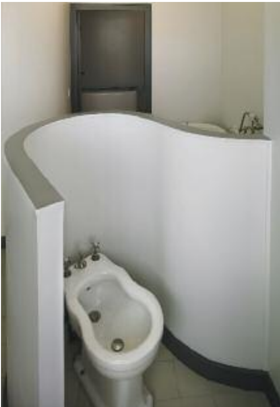
Maison Guiette. La salle à manger, la cuisine et la salle-de-bains. Les cloisons courbes sont très nombreuses dans les réalisations de Le Corbusier. Elles sont souvent associées de manière organique aux pièces d'eau et à l'hygiène du corps : salles de bains, salles d'eau, toilettes. Elles épousent les formes courbes des baignoires, bidets et lavabos. Ph. Kris Vandevorst, octobre 2014.
