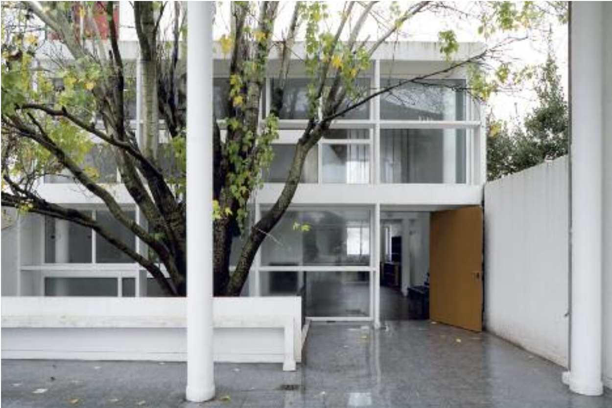
Maison du Docteur Curutchet, La Plata. Vue partielle de la façade du deuxième et du troisième niveau sur la terrasse, en arrière de la façade sur rue. Ph. Olivier Martin-Gambier, 2009.
