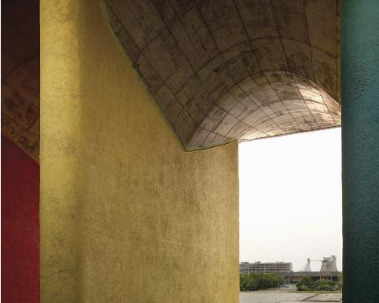
Complexe du Capitole, Chandigarh. Vue de détail des pilotis géants de la salle des pas perdus de la Haute cour de justice. Au loin, on aperçoit le Palais de l'assemblée et en arrière-plan le Secrétariat. Ph. Cemal Emden, 2012.
