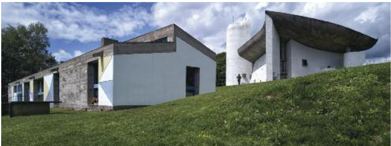
Chapelle Notre-Dame-du-Haut, Ronchamp et, en contrebas, la maison des pèlerins. Ph. Cemal Emden, 2013.
