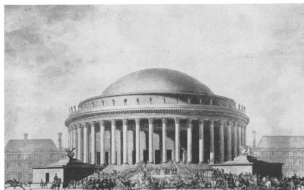
FIG. 25. Opera house—Salle d'opéra.
