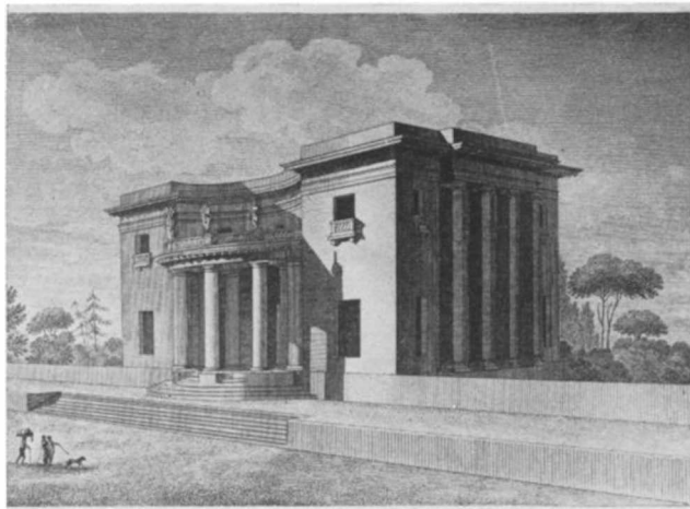
FIG. 162. House of the treasurer—Maison d'un caissier.
