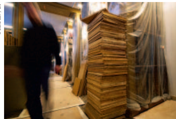
Travaux à la Bibliothèque de l'Arsenal
