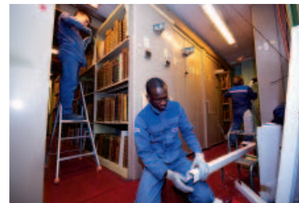
Travaux d'installation des étagères à la Bibliothèque de l'Arsenal
