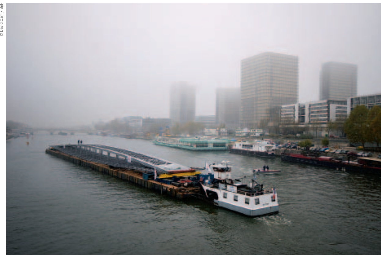
Passerelle Simone de Beauvoir, arrivée de la lentille par transport maritime le 30 novembre 2005
