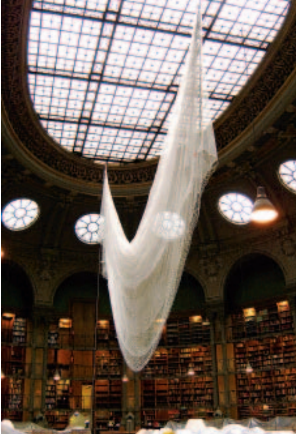
Nettoyage de la verrière au-dessus de la salle ovale ; travaux pendant la fermeture annuelle du site Richelieu
