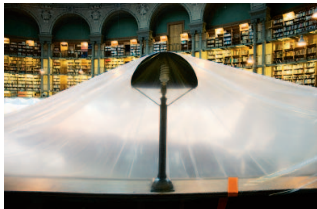
Travaux pendant la fermeture annuelle du site Richelieu, salle Ovale
