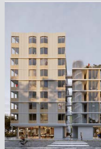
Logements collectifs - Paris
