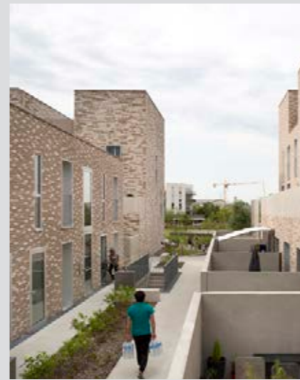
Logements collectifs - Nantes
