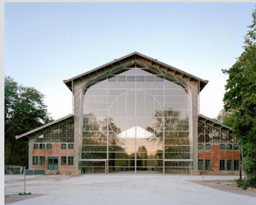
Hangar Y / Meudon
