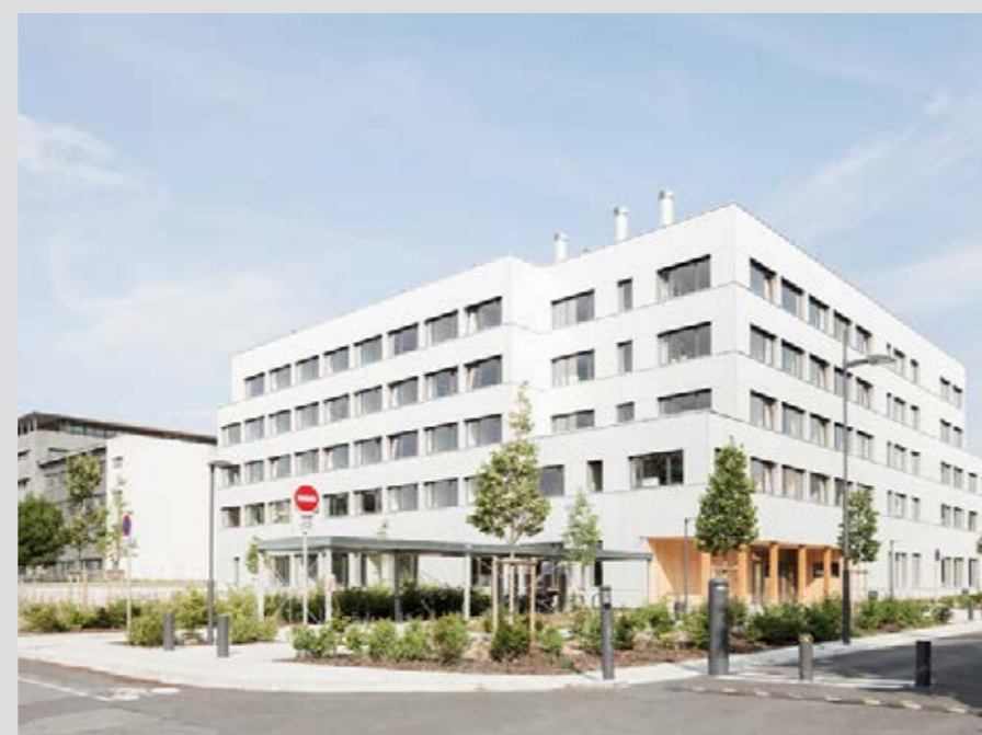
Bâtiment Max Weber, bureaux en bois _ Université Paris Nanterre
