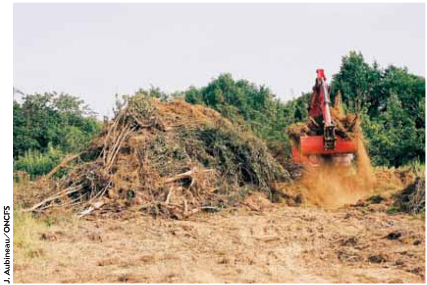
La construction d'une garenne artificielle doit se faire quand la terre n'est pas trop humide pour éviter tout problème de compactage.
