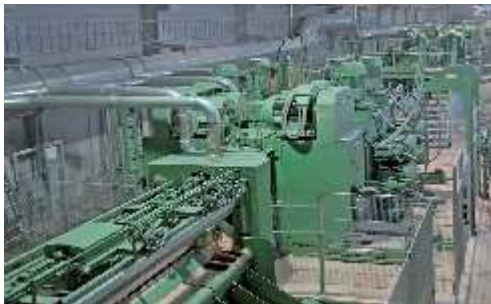
« Mi-temps » : Vue de la ligne jusqu'aux scies de reprise et le bypass
