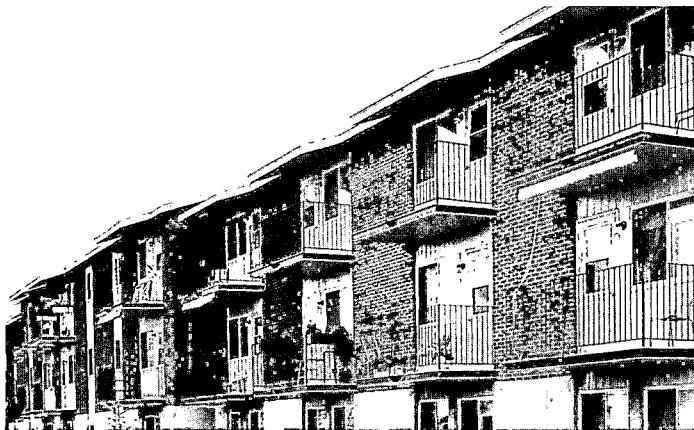
La Villa Marcotte à Drummondville. Après avoir reçu une aide importante d'un Groupe de ressources techniques, les copropriétaires, des personnes retraitées, administrent désormais leur coopérative. La vie de groupe y est intense. Les espaces communautaires, situés au demi-sous-sol, comptent des équipements de loisirs, des ateliers de bricolage, etc.
