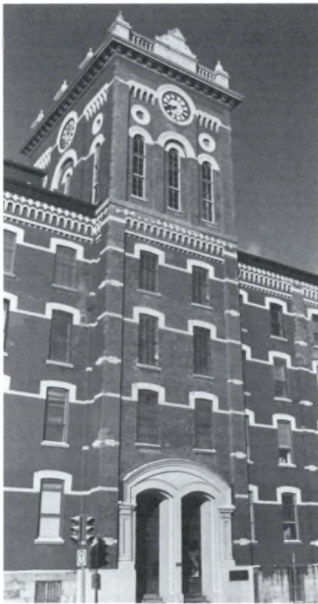
La W.C. MacDonald's Tobacco, rue Ontario est, dans le quartier Hochelaga. Cette usine, encore occupée, est un exemple d'architecture néo-renaissance. L'importante tour carrée, surmontée d'une balustrade et percée de quatre horloges renferme les escaliers.
