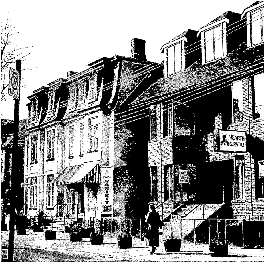
Toronto: une nouvelle typologie. Bâtiment moderne d'inspiration victorienne qui s'insère élégamment dans le contexte d'un quartier ancien.
