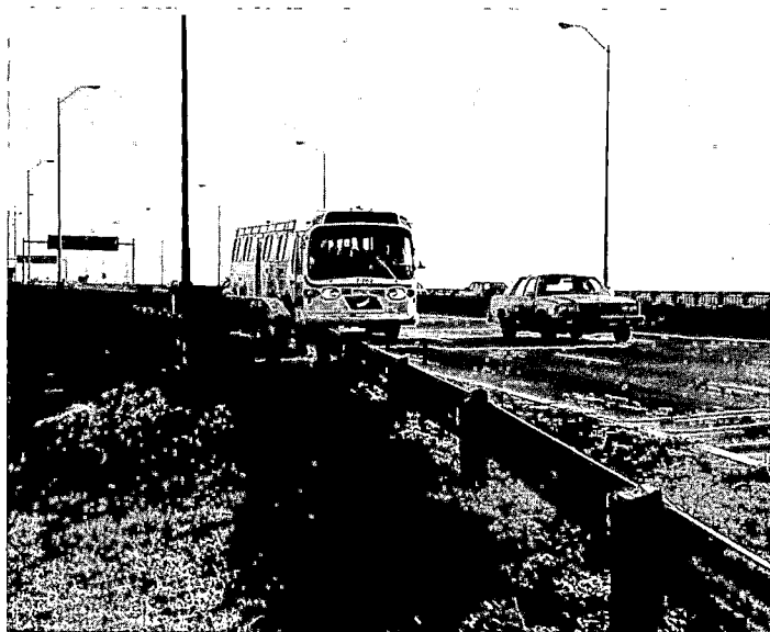
Voie réservée sur le pont Champlain.
