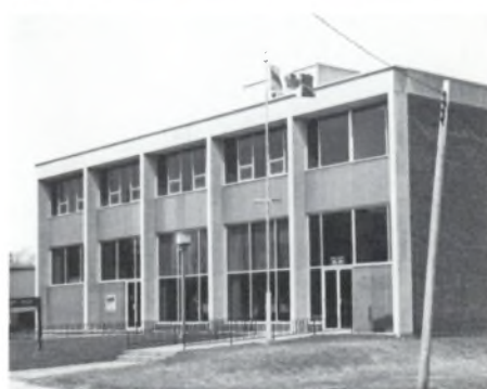
Ancien et nouveau bureaux de poste de Beauharnois. L'ancien bureau de poste situé à l'extrémité nord de ce qui fut un marché, traduit bien le souci que l'on avait d'une architecture civique. À l'opposé de cette conception, le nouveau bureau de poste marque bien l'indifférence qui résulte d'une logique interne à toute grande institution dépersonnalisée.
