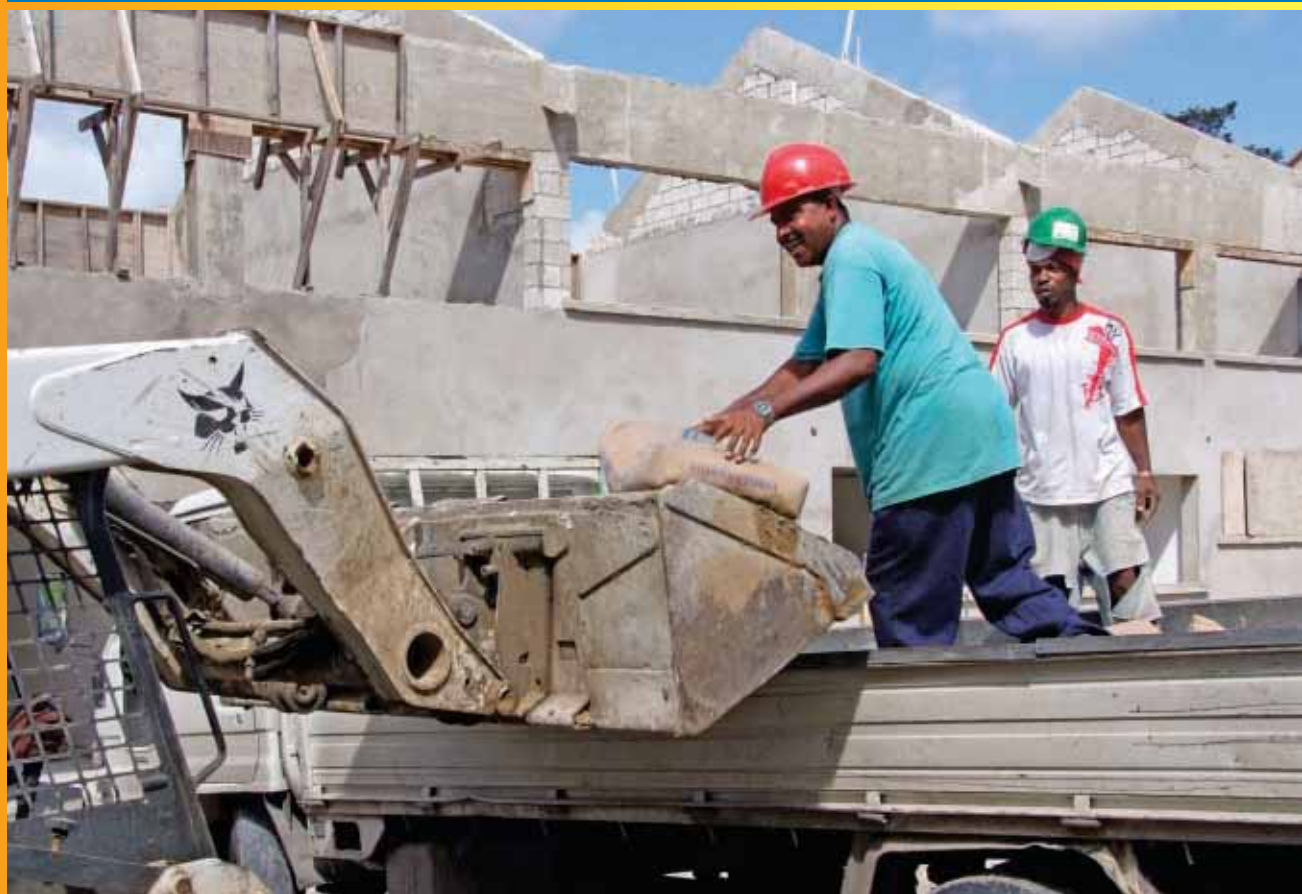
Barbade • Construction de l'école primaire Carrington-Erdiston, dans le cadre d'un vaste projet éducatif.
