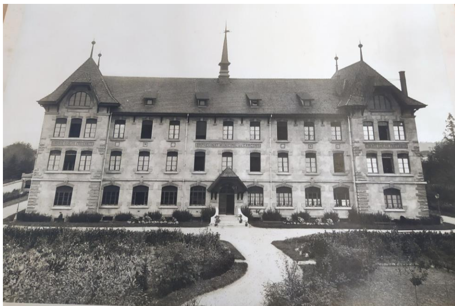
AML 2494W1 : Entrée principale du bâtiment, 1955-1989.
