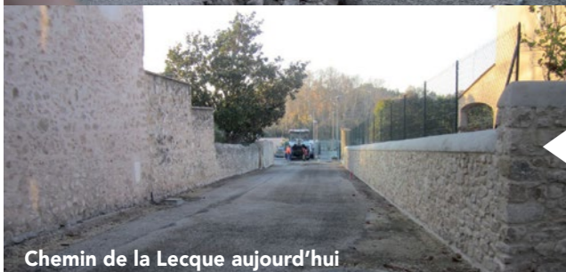
Chemin de la Lecque en travaux
