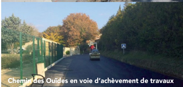
Chemin des Ouides en travaux
