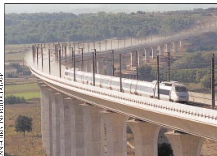
Essais sur le gigantesque viaduc de Ventabren (1 700 m), au nord-ouest d'Aix-en-Provence.
