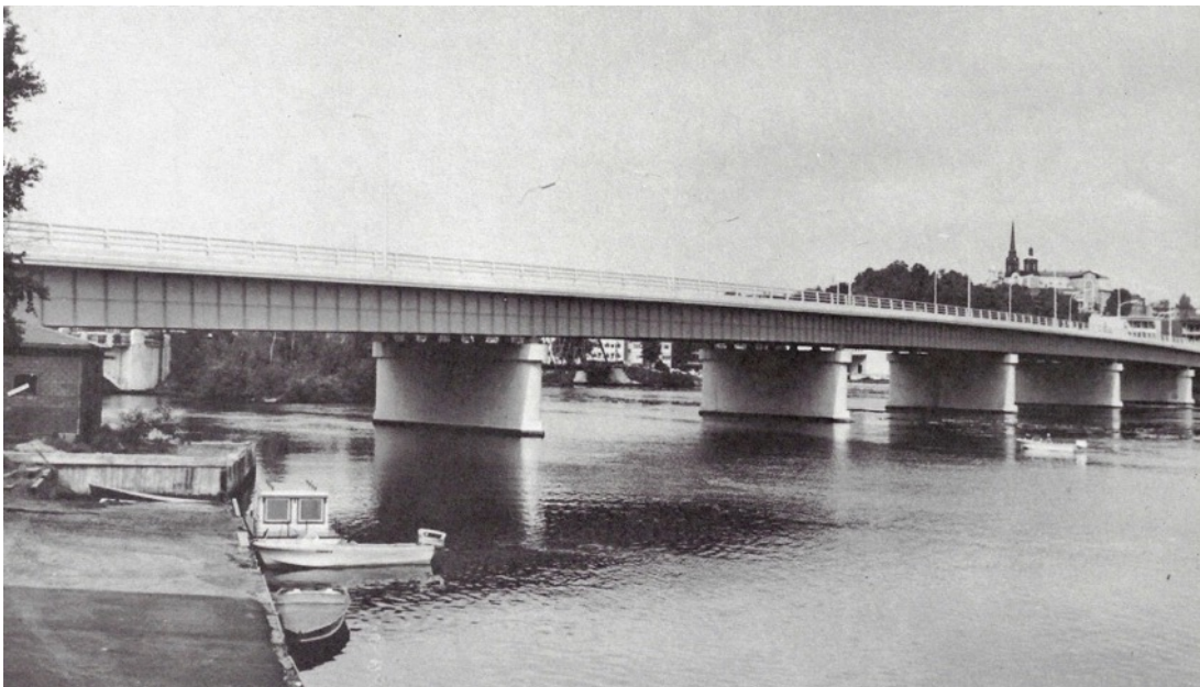
Source : Brochure Demers Lemieux Roy. Pont de Shawinigan, 1965.
