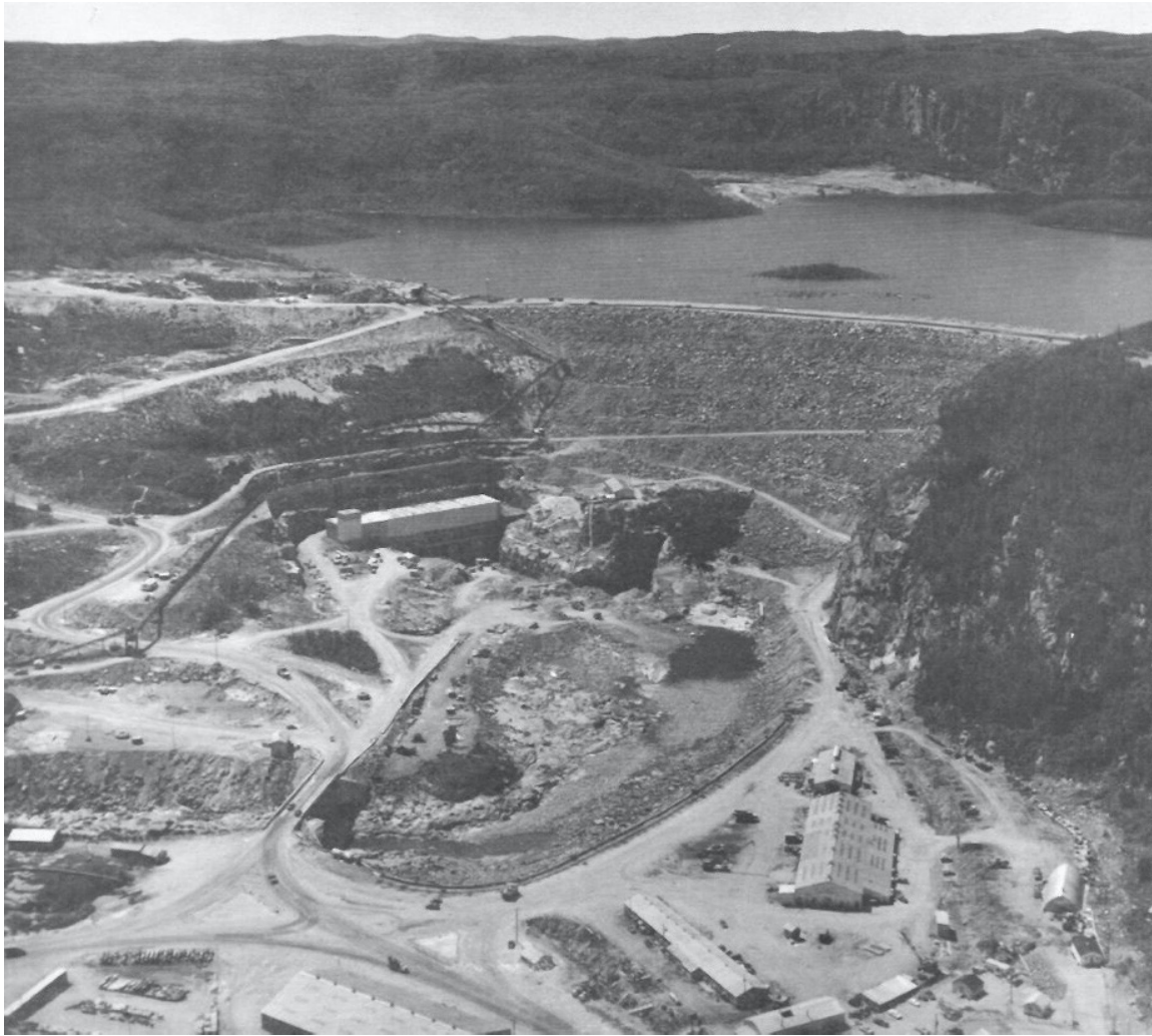
Outardes 4 - Vue générale du barrage principal, de la centrale et de la sortie de la galerie de dérivation, Photo H-Q, Septembre 1968
