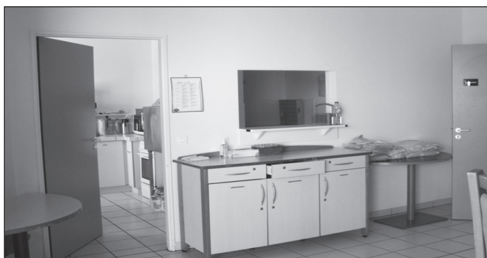
Afin de travailler sur les aspects sensoriels visuels et olfactifs, des petits passe-plats ont été réalisés entre les offices et les salles à manger.
