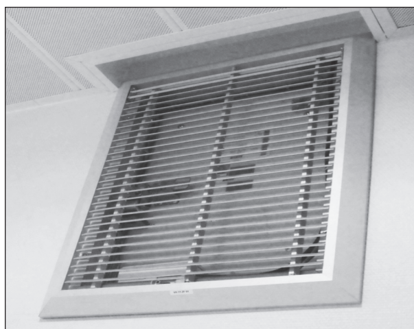
Une des premières difficultés techniques a été de faire coïncider les aspects liés à la sécurité incendie à la vie des personnes hospitalisées dans le service.
