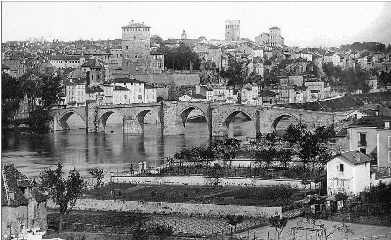
CAHORS. LE PONT NEUF démoli en 1906. Photographie sur plaque de verre.
