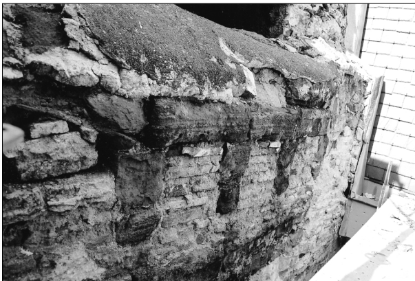
BAYONNE. Trous maçonnés pour l'évacuation de l'eau pluviale au faite du mur M2.
