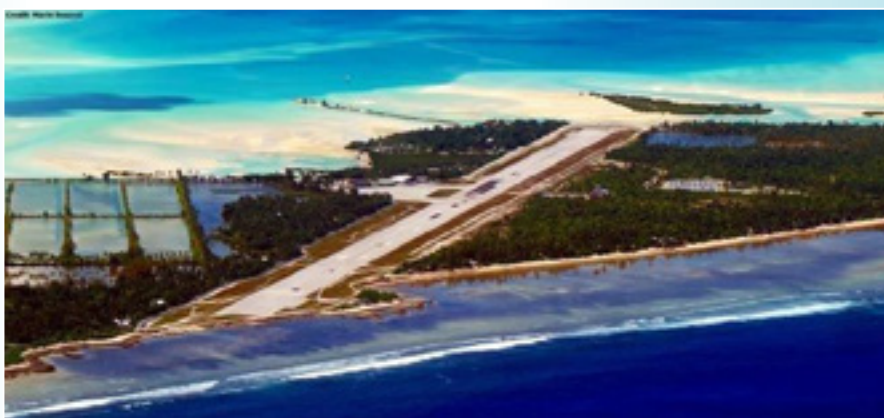
Réserve d'eau de Bonriki, Tarawa Sud (Kiribati).
