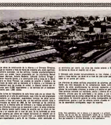
Arriba: En realidad, la alberca y el gimnasio olímpicos son dos edificios, como se ve en esta fotografía aérea. A partir de una fila central de columnas, el gran techo toma una delicada línea sobre la alberca y el gimnasio, dando al interior una capacidad de visión libre de obstáculos. Para: Dos
