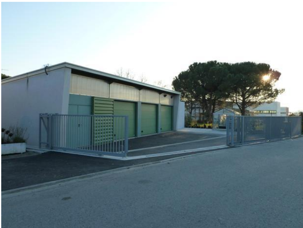
Figure V-28 : Vue extérieure de la plateforme se trouvant sur le site de l'INP-Toulouse à Labège
