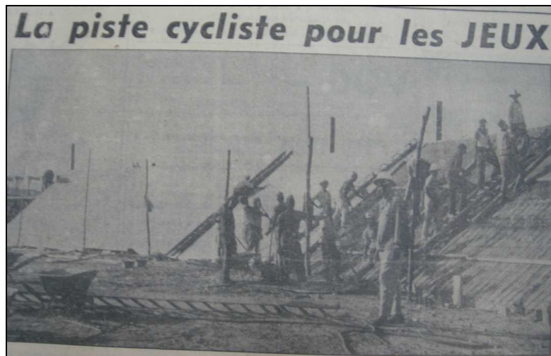
144. La piste cycliste ou vélodrome en construction, Dakar-Matin , 01/1963, (Archives ANS).
