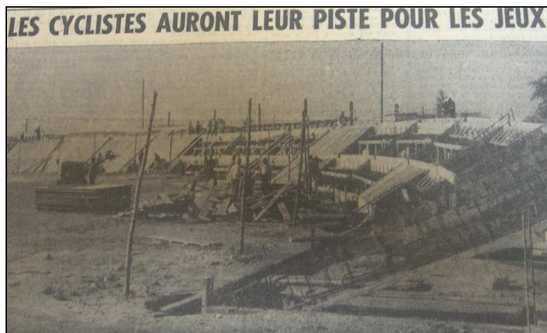
145. La piste cycliste ou vélodrome en construction, Dakar-Matin , 01/1963, (Archives ANS).
